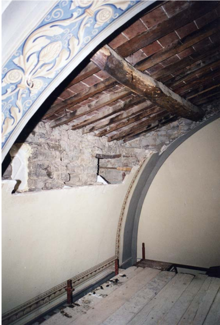
FOTO 3: volta e copertura dell'aula in prossimità della facciata
