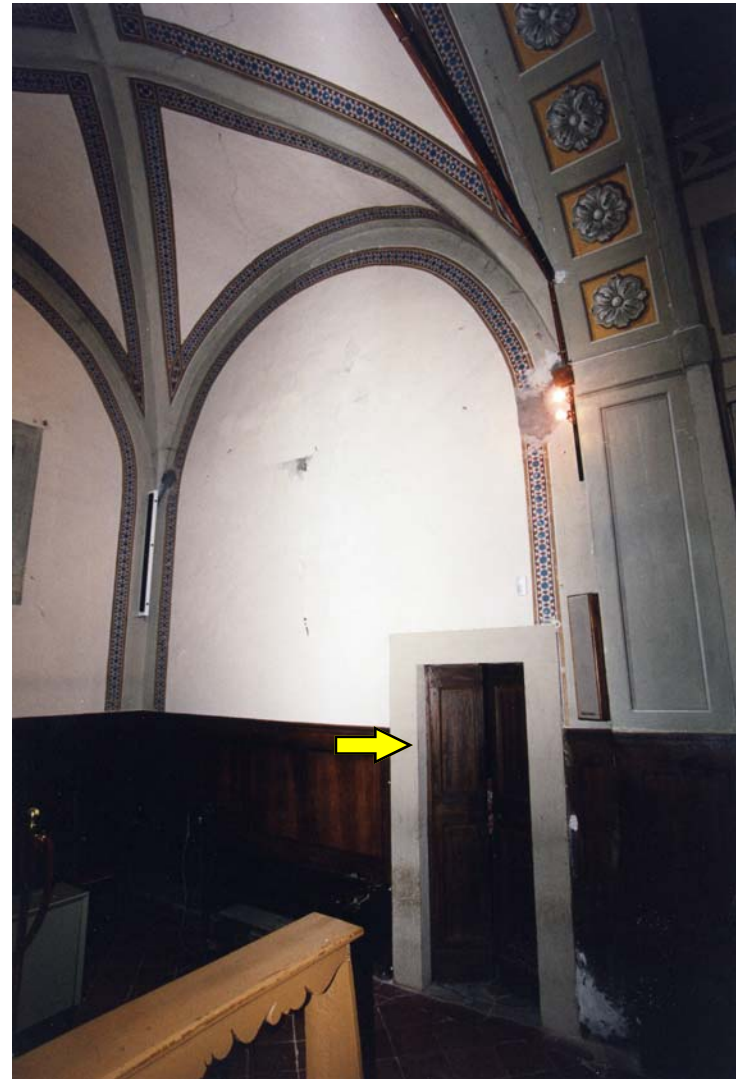
FOTO 12: parete destra dell'abside
