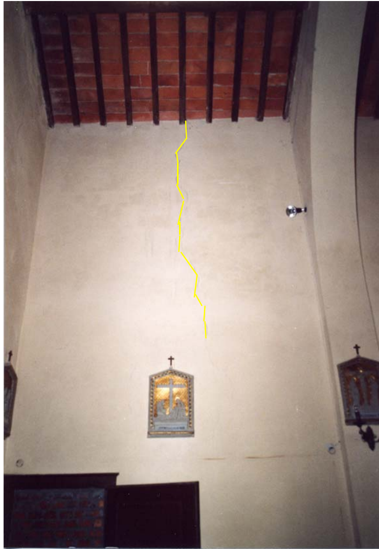
FOTO 23: parete laterale sinistra
