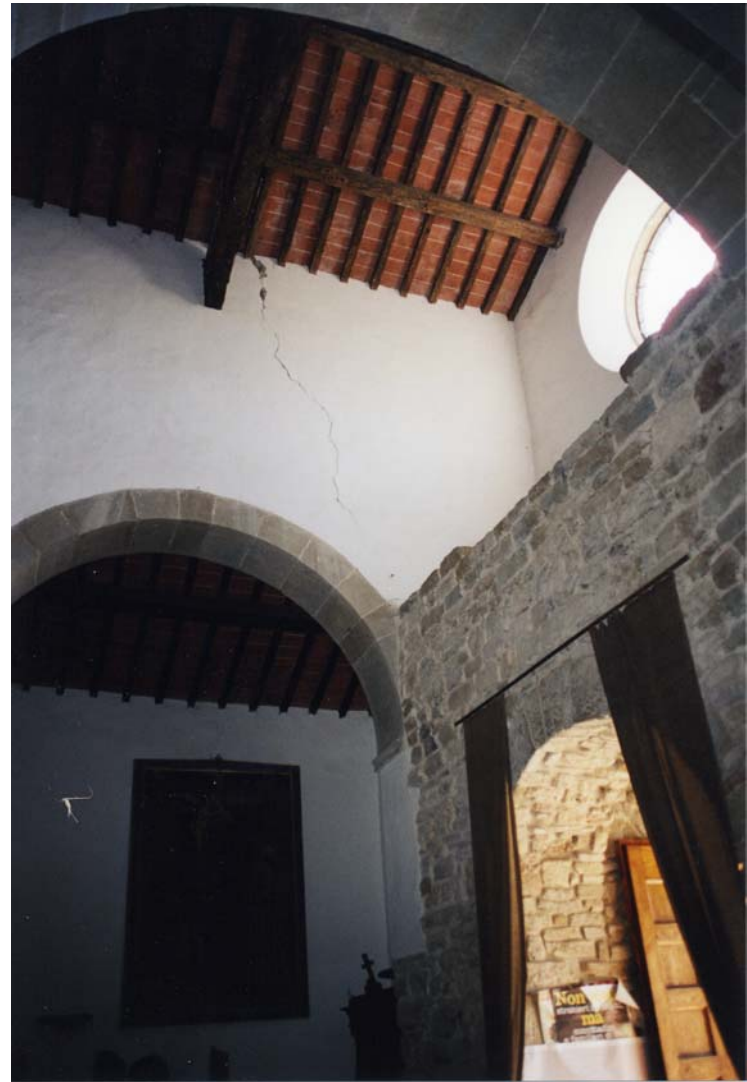
FOTO 6: ingresso e parete laterale destra della navata centrale
