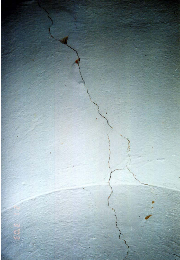
FOTO 33: facciata - lato interno
