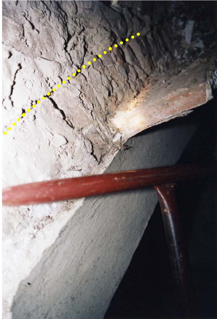
FOTO 9: particolare del collegamento fra volta e arco trasversale
