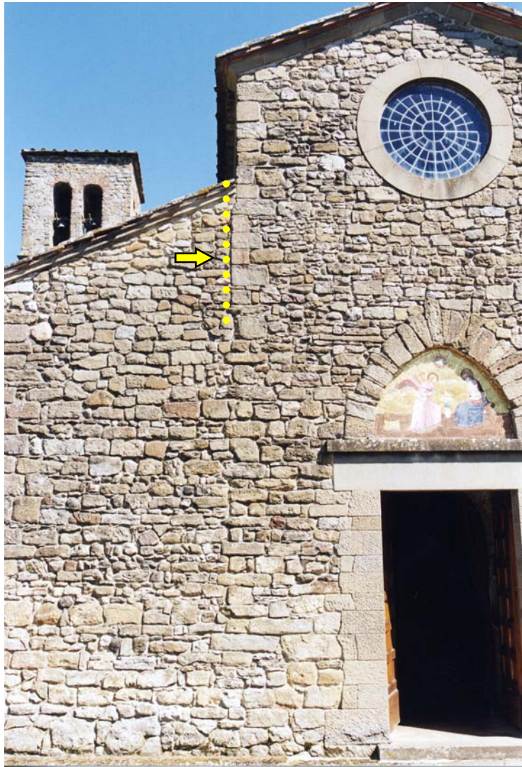
FOTO 13: facciata - parte sinistra
