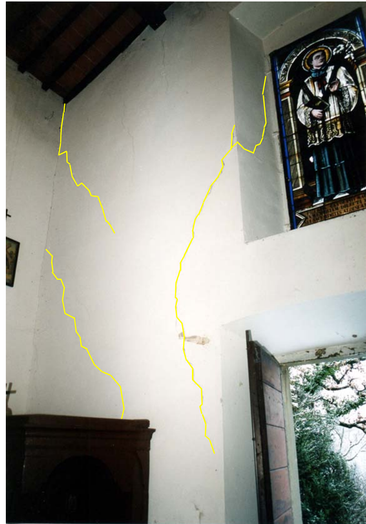
FOTO 10: facciata - parete laterale destra
