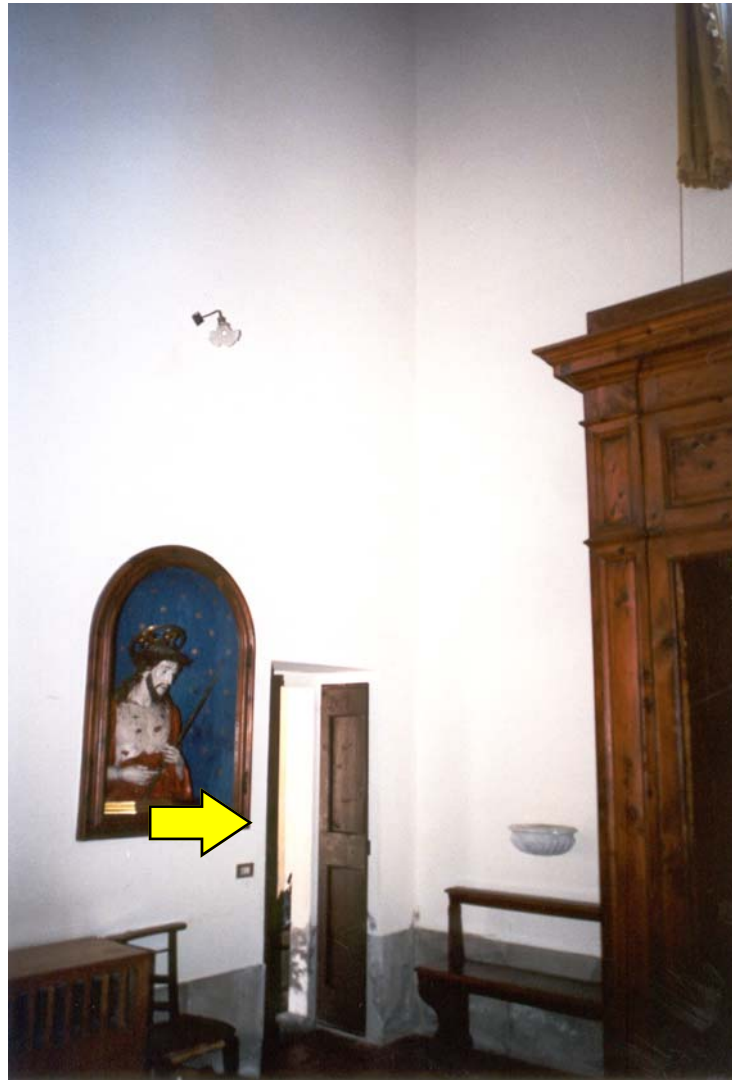
FOTO 9: fascia di sovrapposizione tra facciata e parete laterale destra
