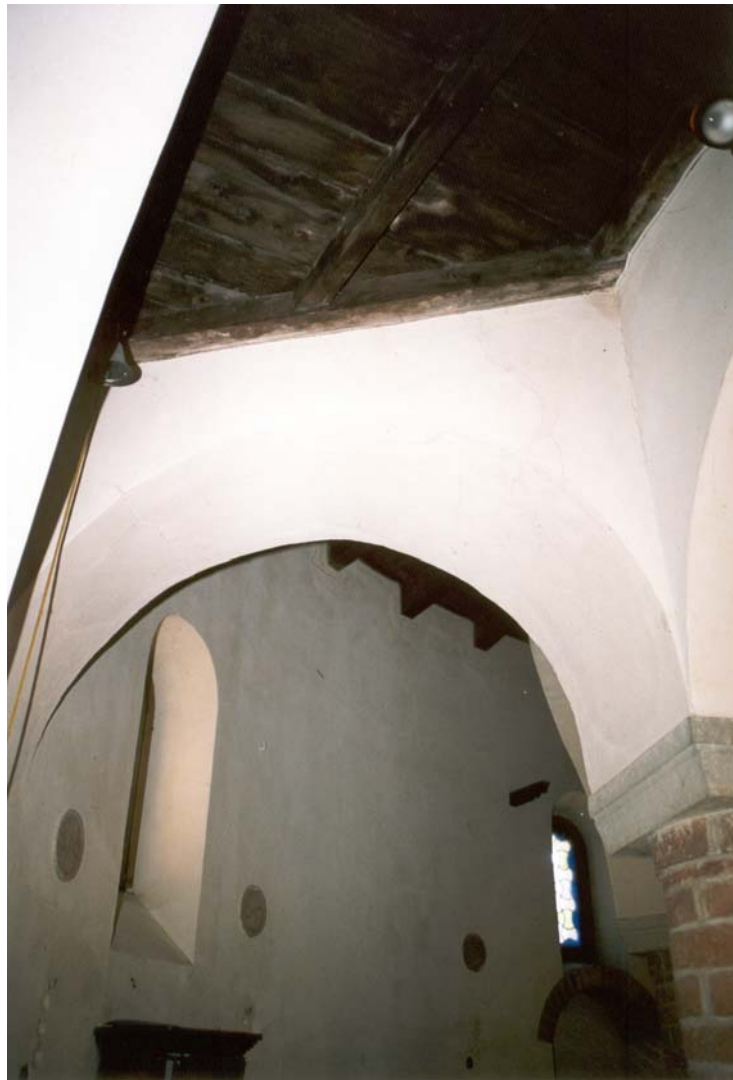
FOTO 9: arco di collegamento destro fra anello centrale dell'aula e presbiterio
