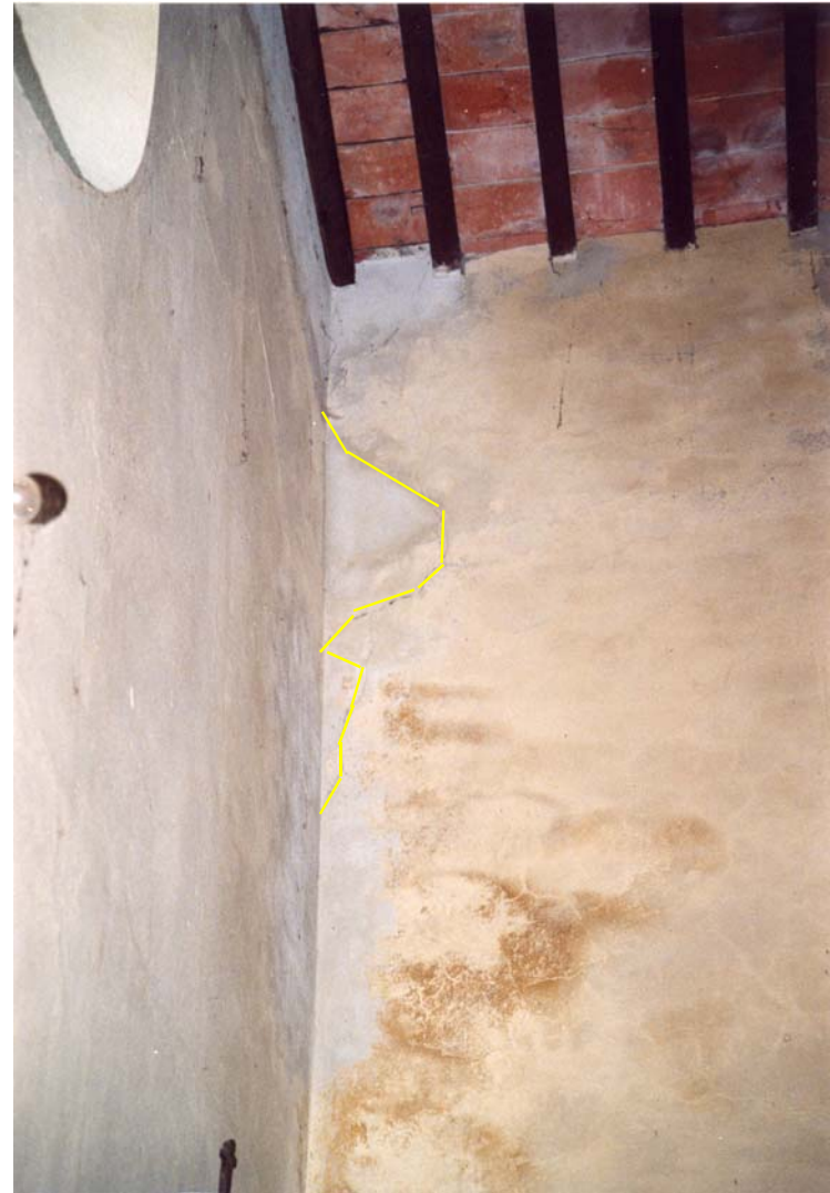
FOTO 22: parete laterale sinistra
