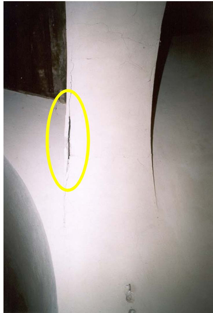
FOTO 14: arco di collegamento sinistro fra anello centrale dell'aula e avancorpo d'ingresso
