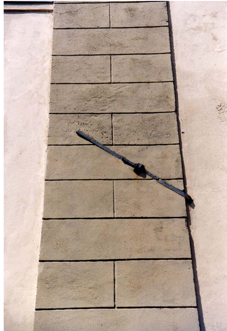
FOTO 8: capochiave del tirante longitudinale sinistro
