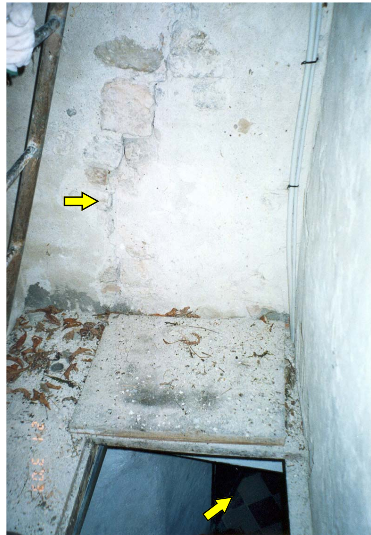
FOTO 36: parete laterale sinistra del campanile
