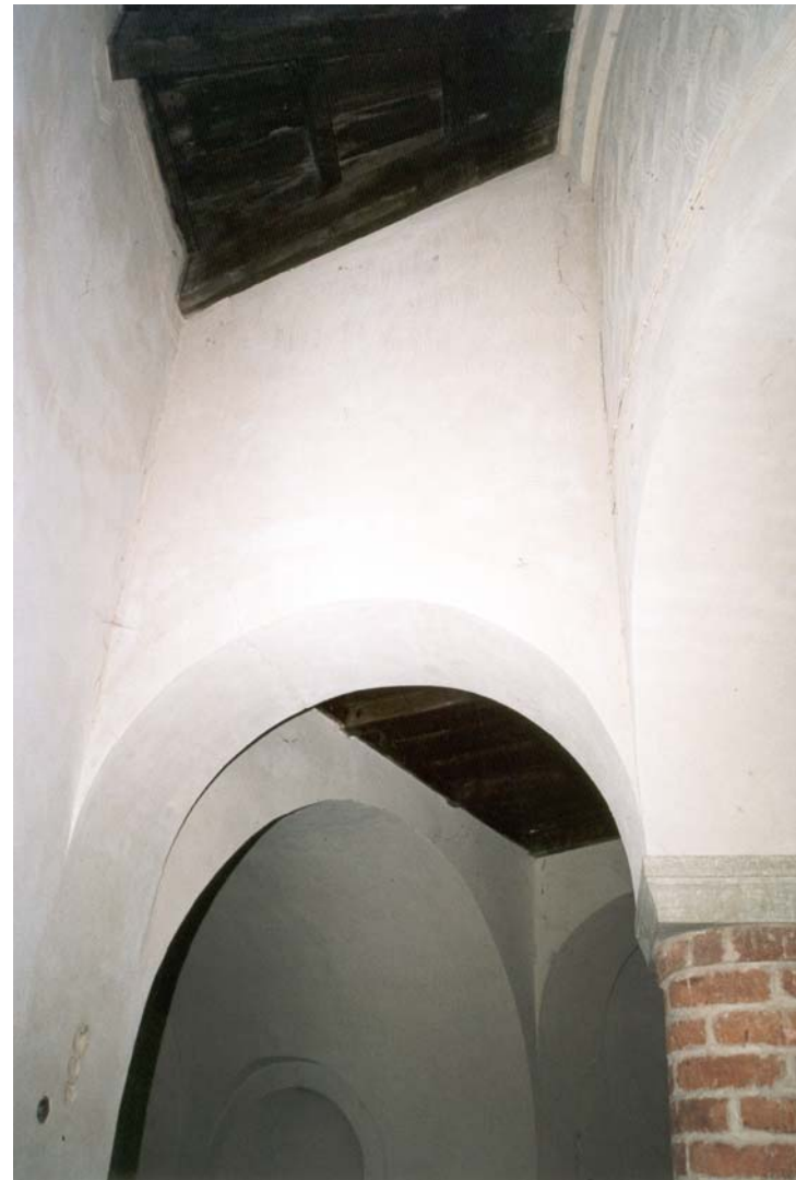
FOTO 10: arco di collegamento destro fra anello centrale dell'aula e avancorpo d'ingresso
