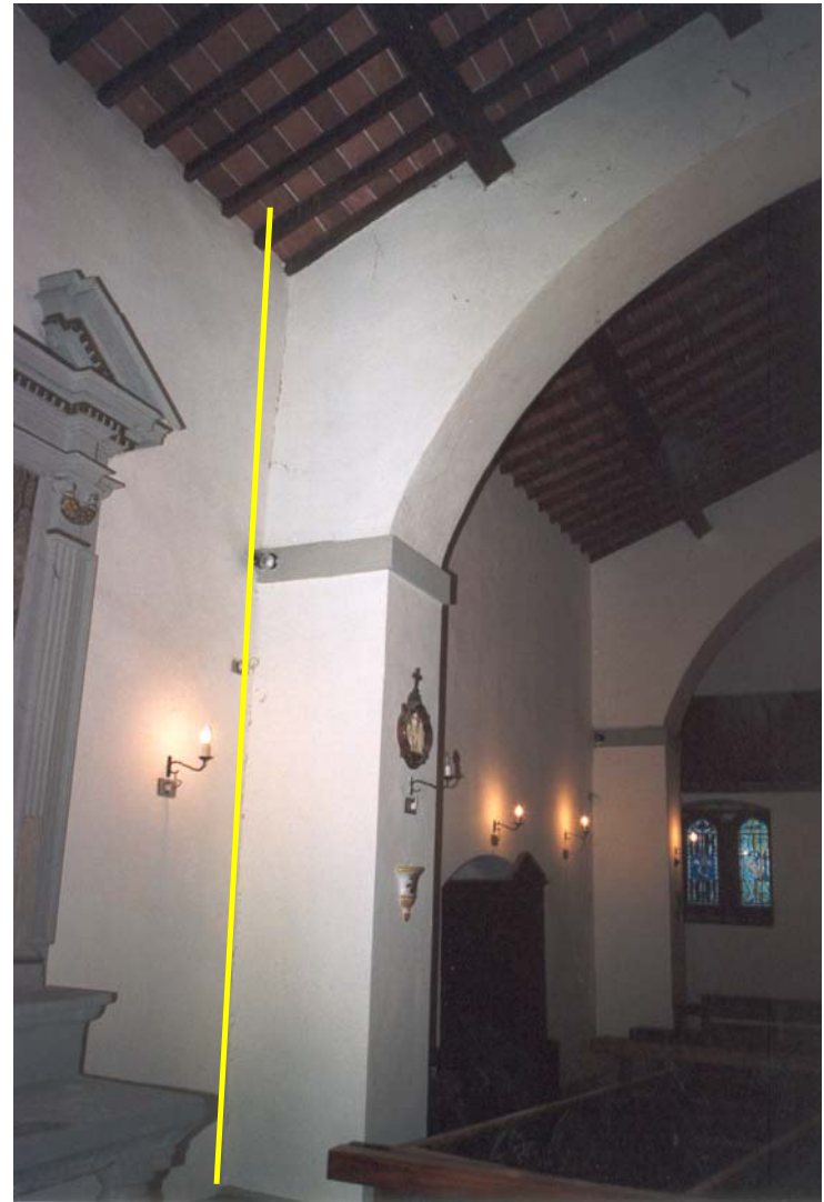
FOTO 18: piedritto destro del secondo arco trasversale destro
