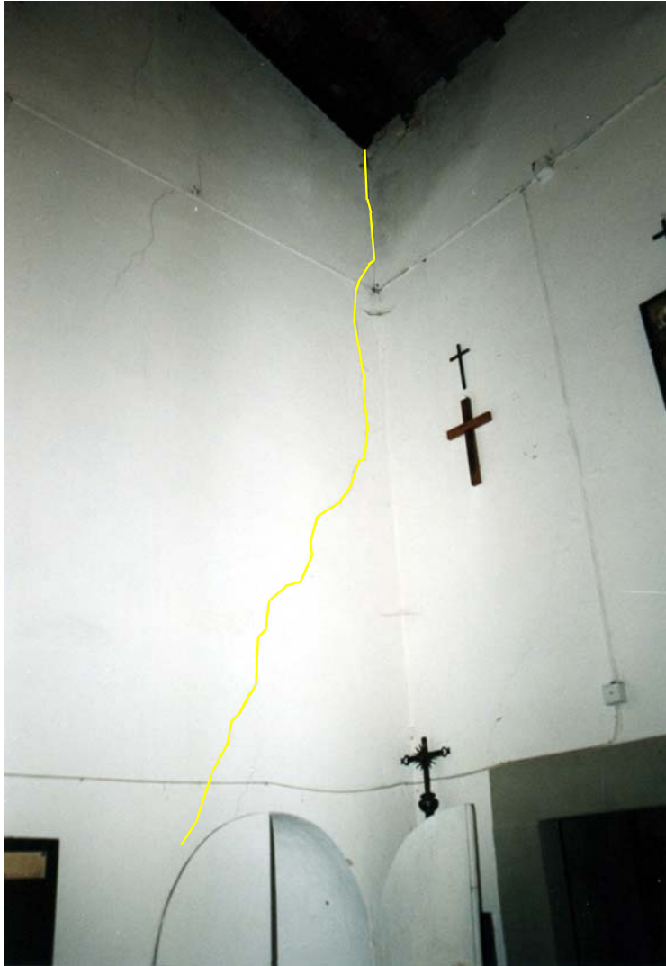
FOTO 14: facciata - parete laterale sinistra
