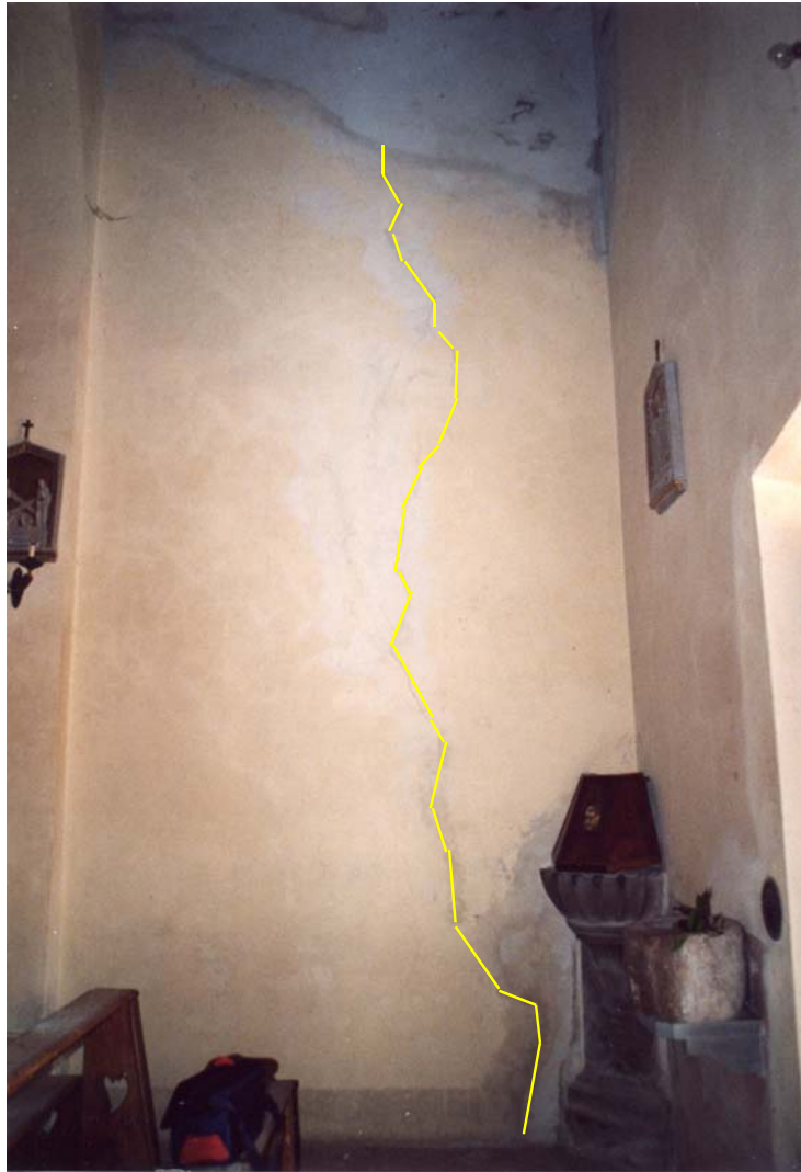
FOTO 21: parete laterale destra
