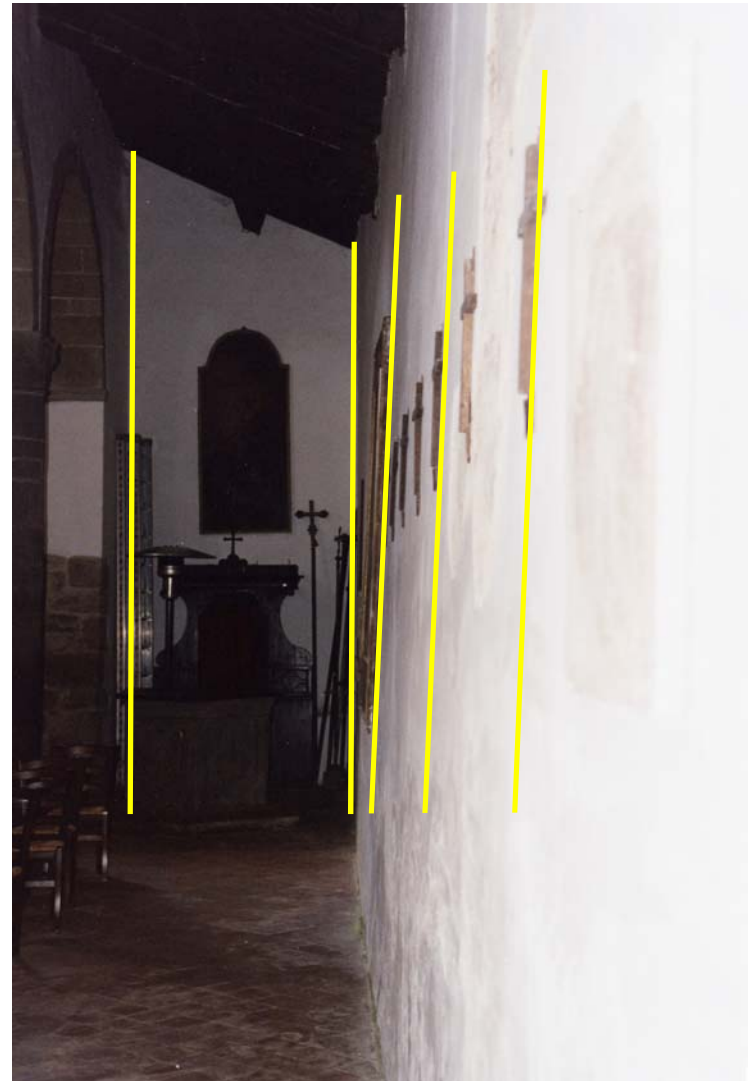
FOTO 19: parete laterale della navata sinistra
