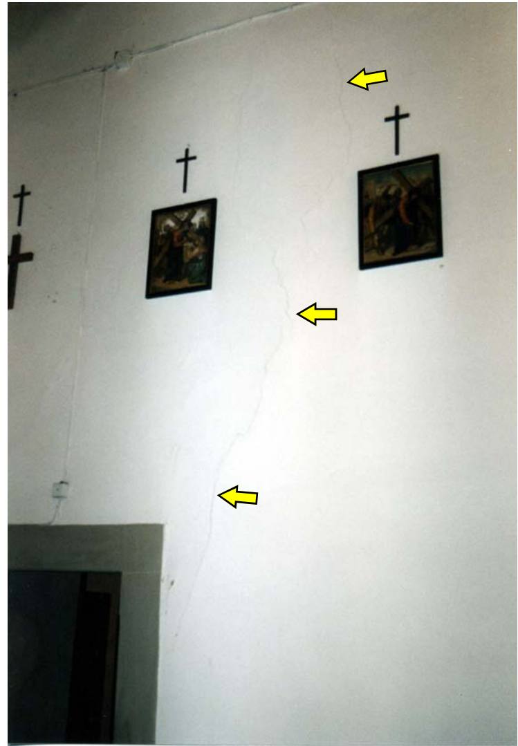
FOTO 15: parete laterale sinistra
