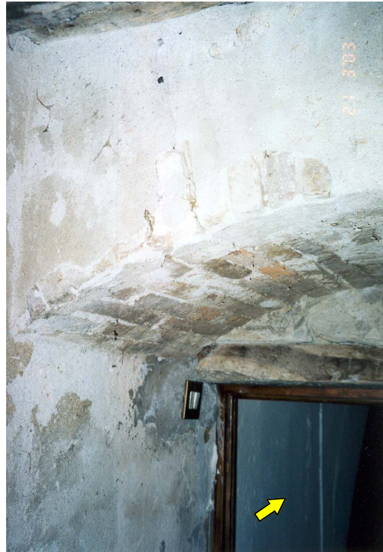
FOTO 34: passaggio chiesa - canonica al di sotto del campanile
