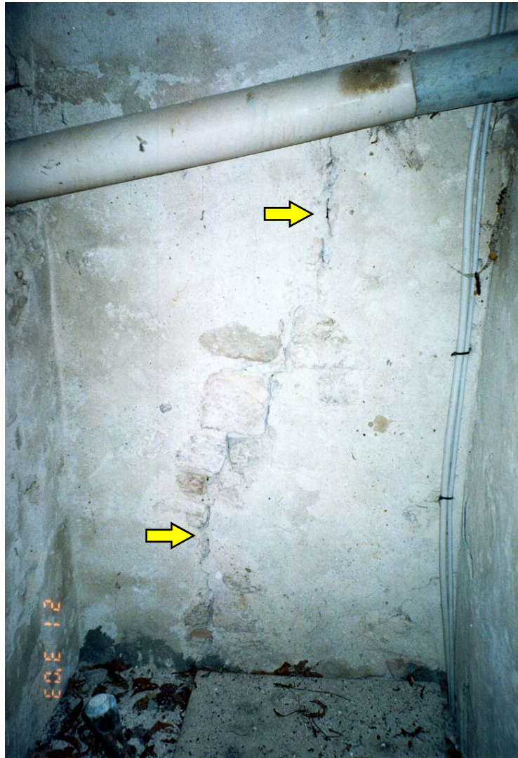
FOTO 35: parete laterale sinistra del campanile
