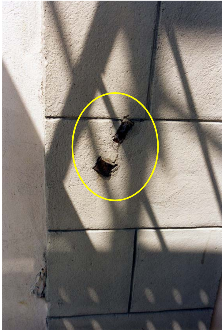
FOTO 7: capochiave del tirante longitudinale destro
