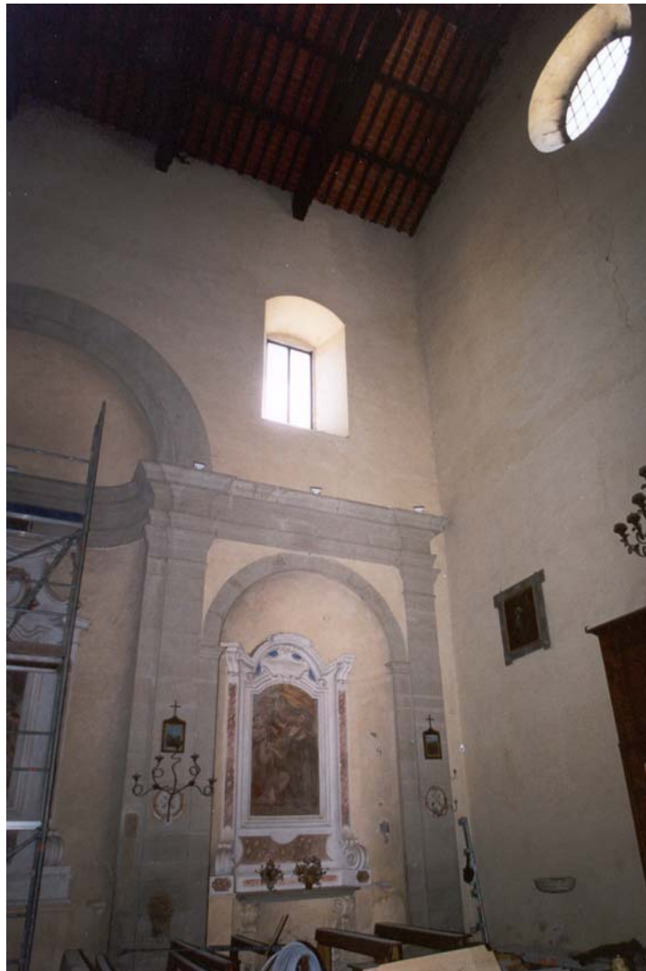
FOTO 3: angolata fra parete laterale destra e facciata
