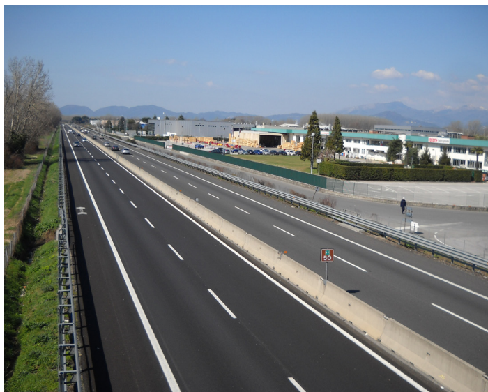
Asse autostradale A11 ed urbanizzato industriale (area industriale di Carraia), con rilevante effetto di barriera ecologica sulla pianura lucchese (foto L. Lombardi, archivio NEMO)
