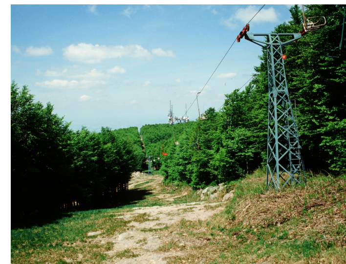
Processi di artificializzazione della zona sommitale del Monte Amiata, con seggiovie e piste da sci nell'ambito delle rare faggete su vulcaniti e presenza di impianti per telecomunicazioni. (Foto: L. Lombardi, archivio NEMO)
