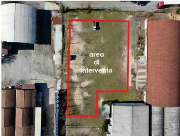
FOTO DRONE 03 – "campo B"
