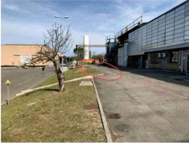
FOTO 04 – area dove verrà realizzata la nuova cabina elettrica
