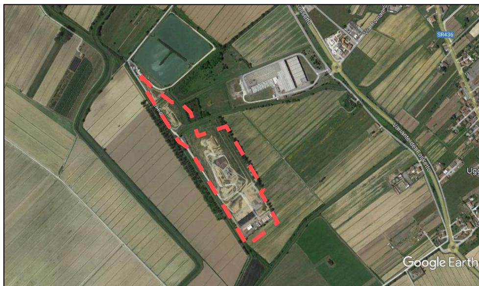
Figura 3 – Inquadramento dell'impianto (fonte Google Earth)
