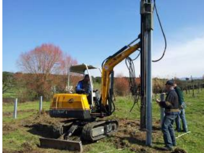
Figura 24 – Particolare infissione Strutture a terra
