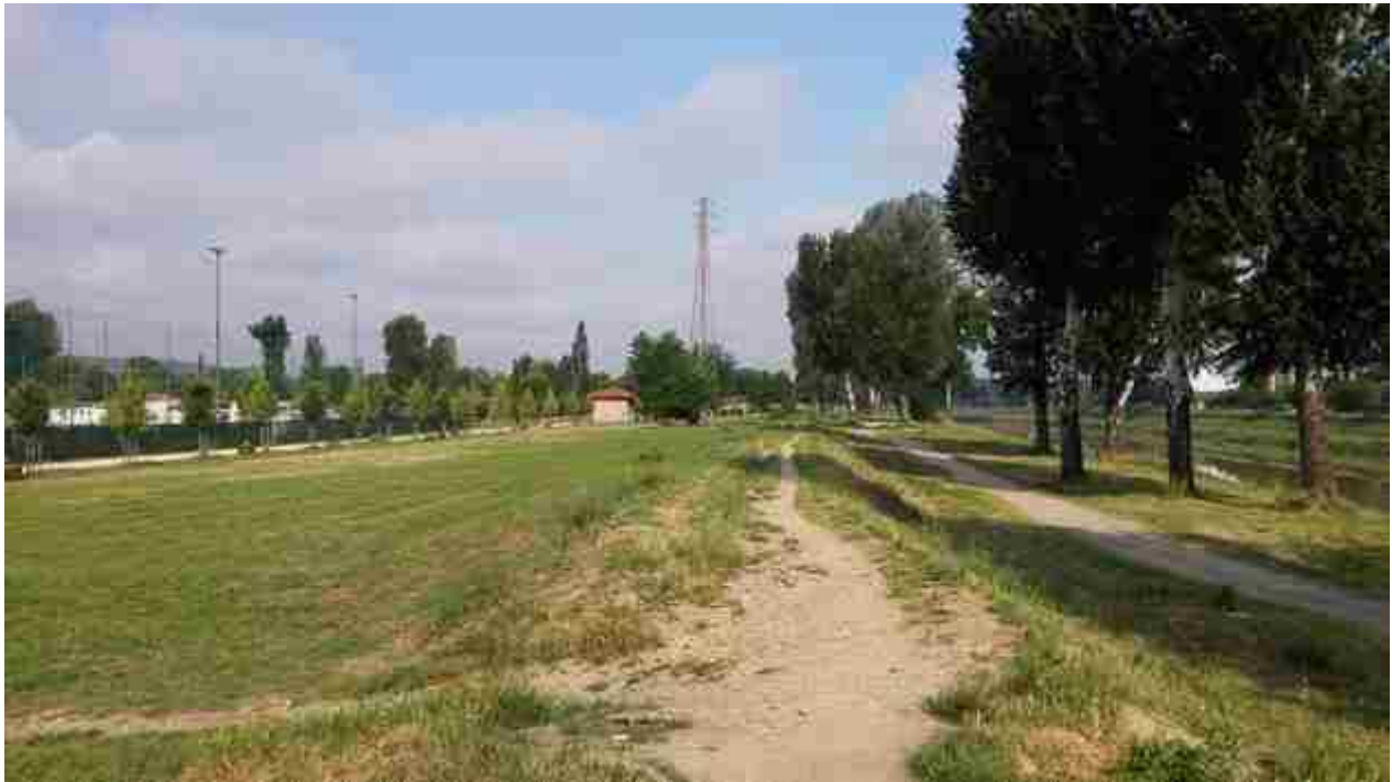
05_05 rialzo argine zona campo sportivo
