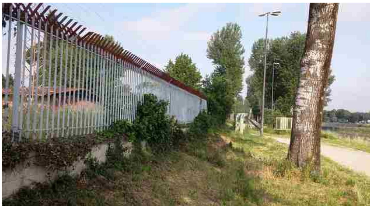
06_01 muro impianto dell'Anconella
