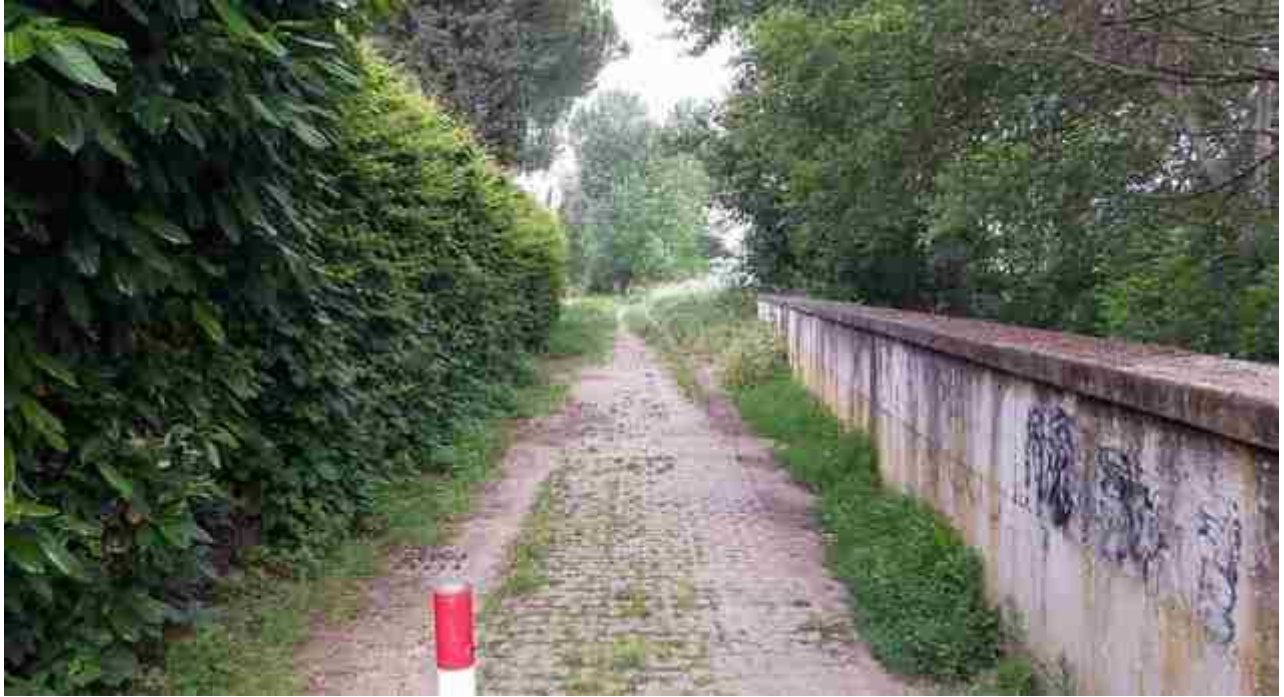
02_04 rialzo muro in calcestruzzo
