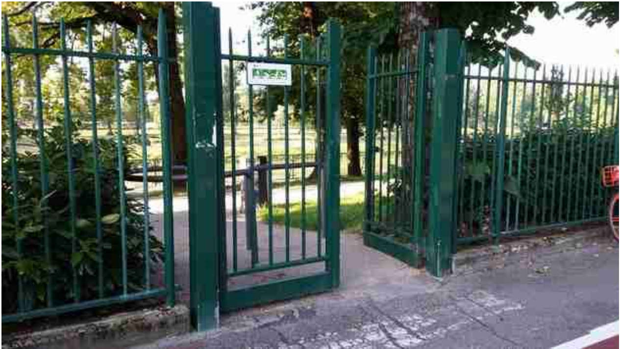
08_06 rialzamento cordolo varco3
