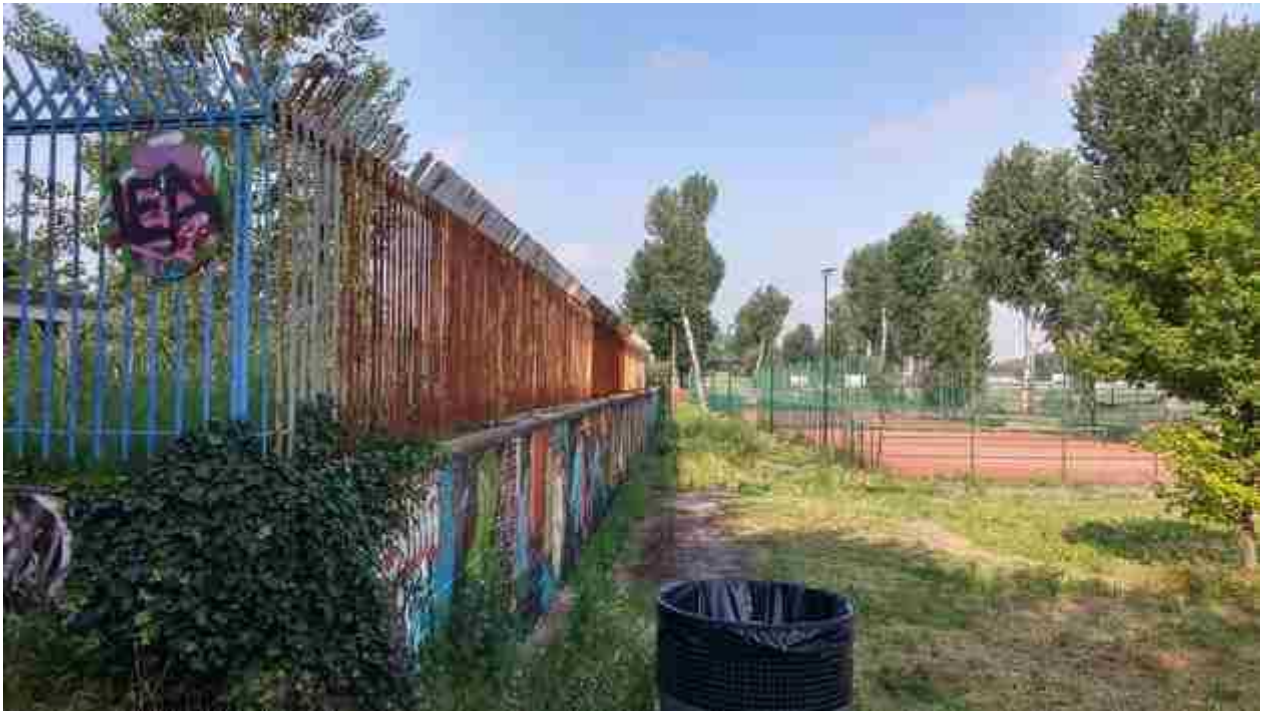
06_09 muro impianto dell'Anconella
