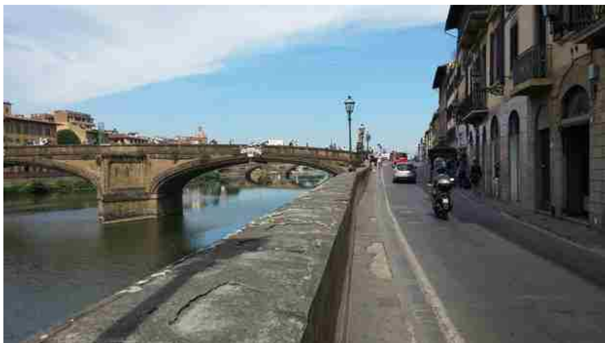
25_04 rialzo spallette Lungarno Acciaiuoli
