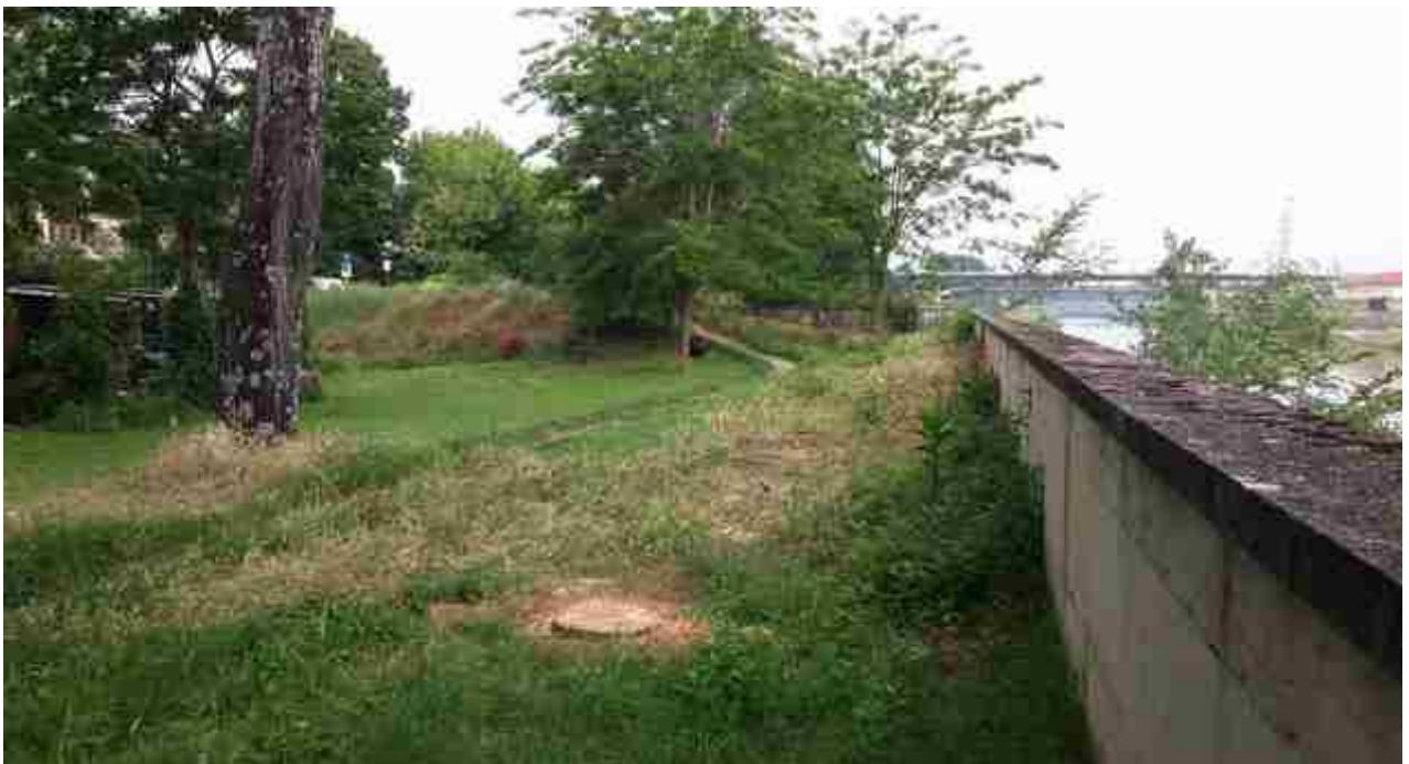
02_05 rialzo muro in calcestruzzo
