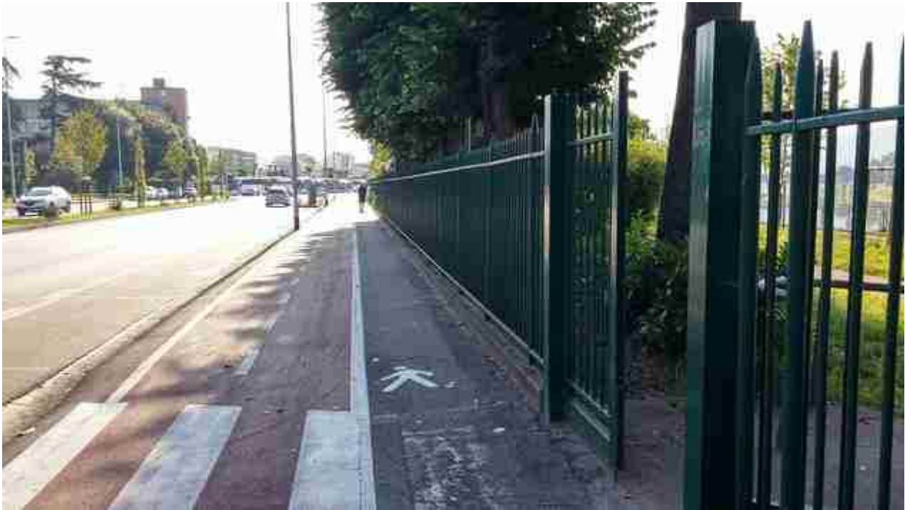
08_04 rialzamento cordolo vista verso monte
