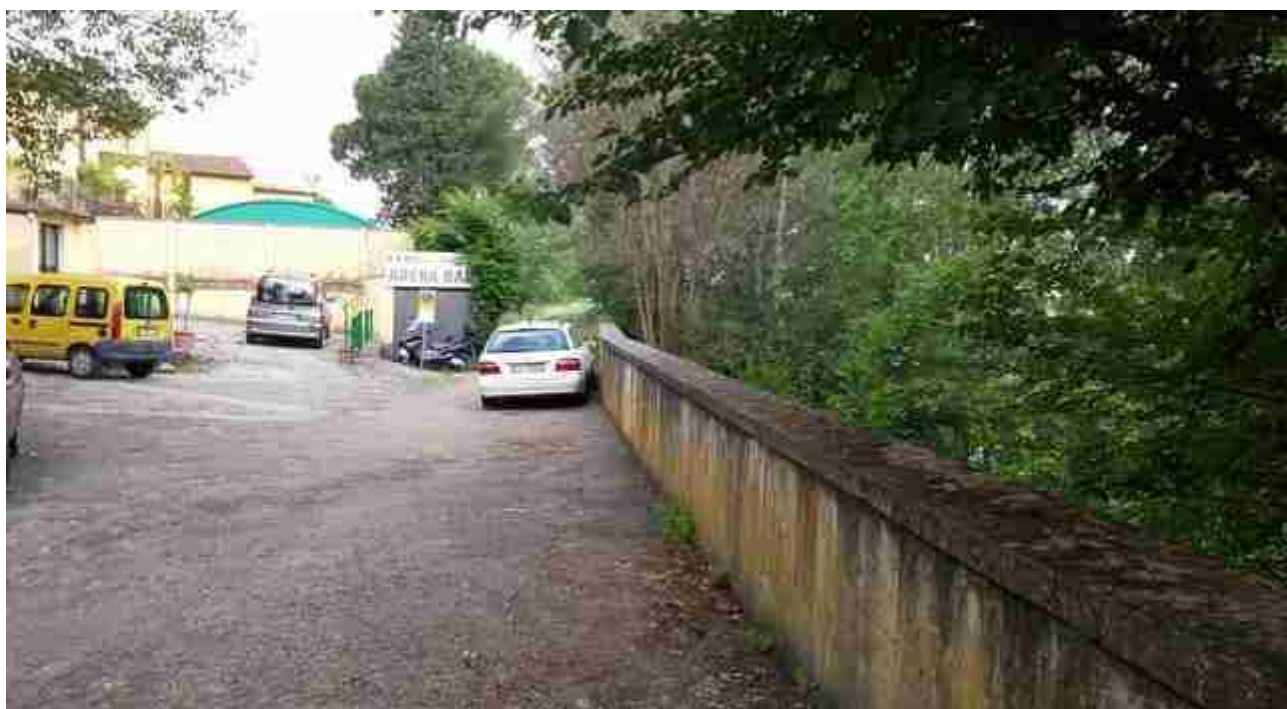
02_03 rialzo muro in calcestruzzo
