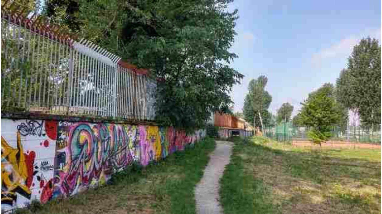
06_07 muro impianto dell'Anconella con rampe di risalita dalla golena controcorrente
