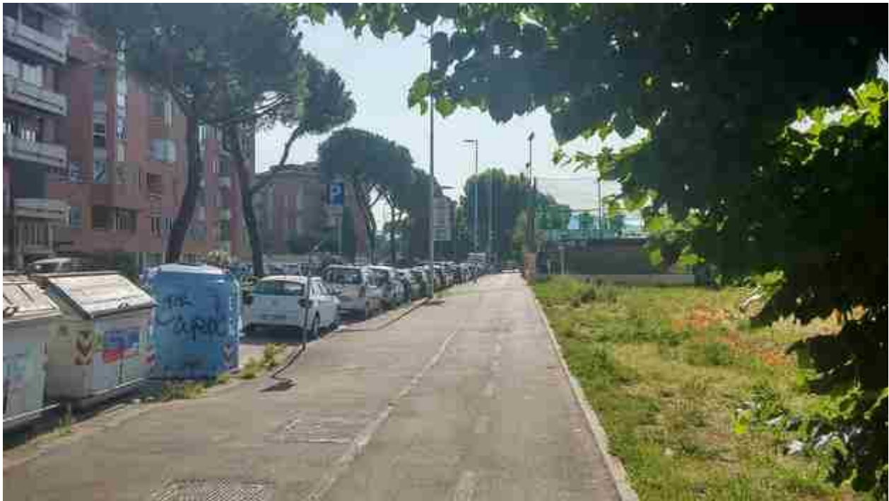
14_02 realizzazione spalletta vista verso monte
