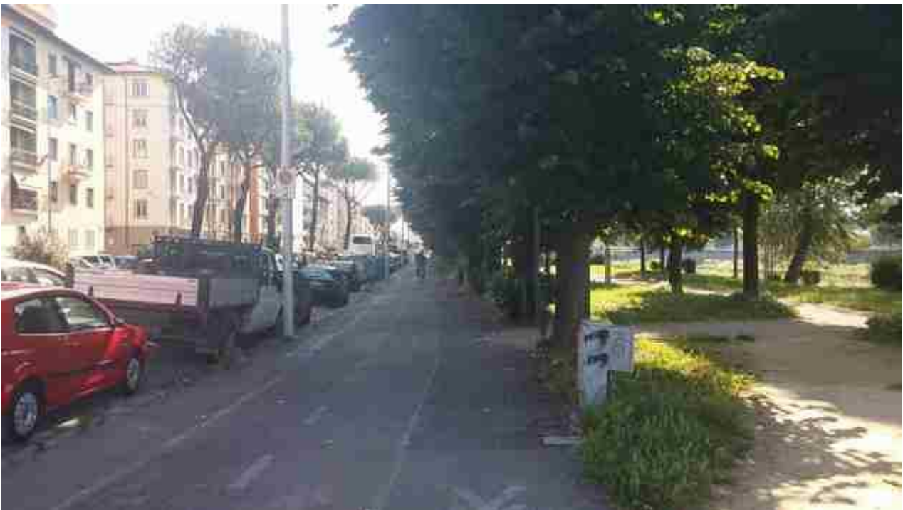
11_03 realizzazione spalletta vista verso monte
