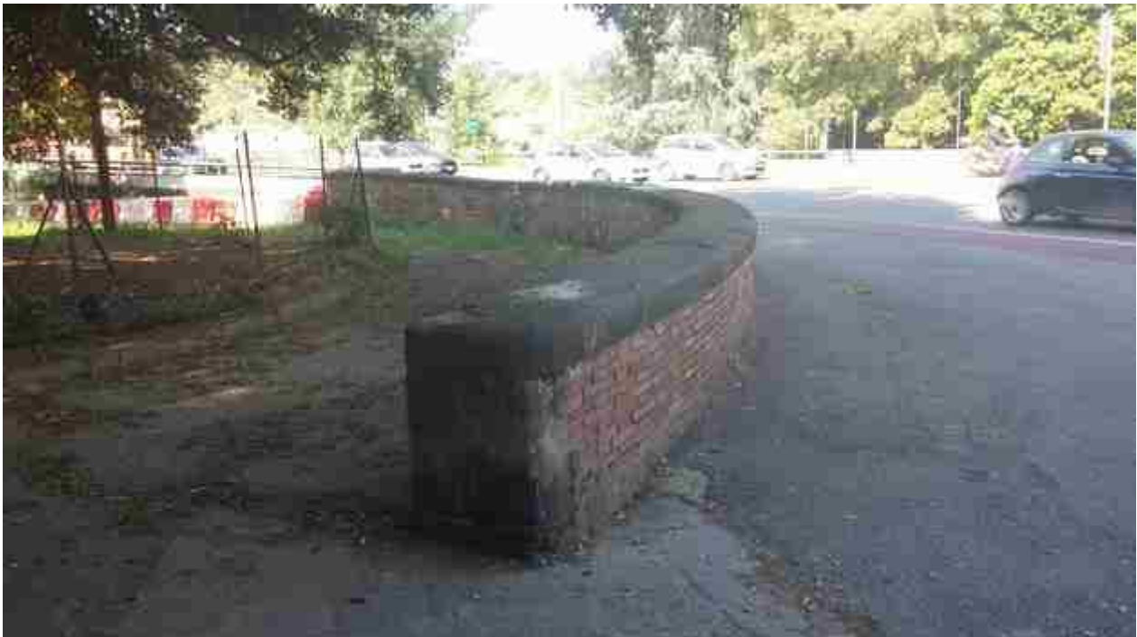
23_01 realizzazione spalletta con varco
