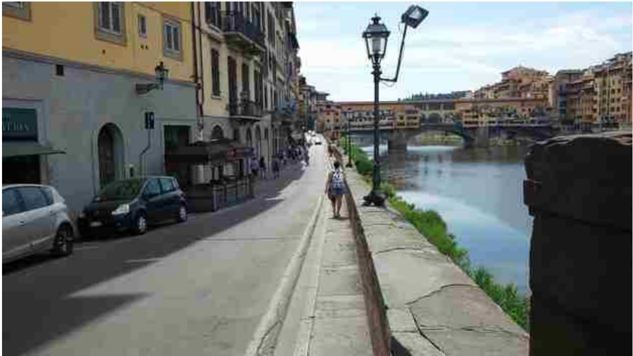
25_05 rialzo spallette Lungarno Acciaiuoli vista verso monte
