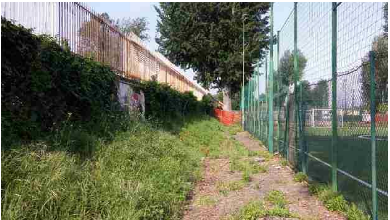
06_12 muro impianto dell'Anconella
