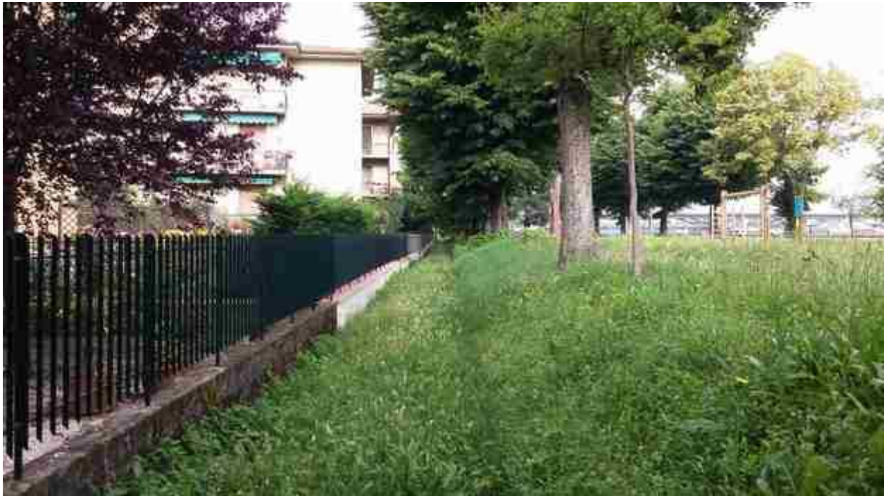
03_04 particolare petto argine a campagna
