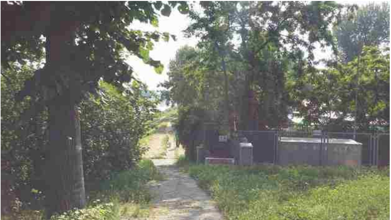
08_06 attacco al Ponte Giovanni da Verrazzano vista verso monte
