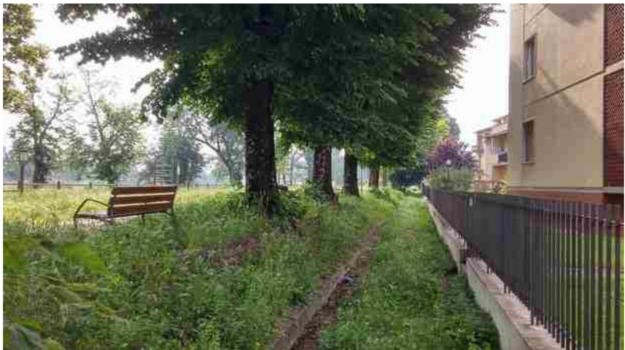
03_06 particolare petto argine a campagna vista verso monte
