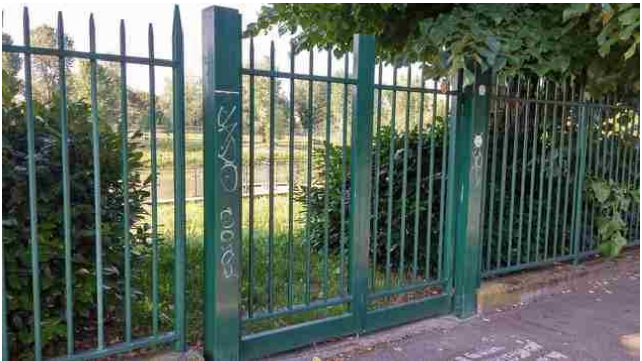
08_09 rialzamento cordolo varco5
