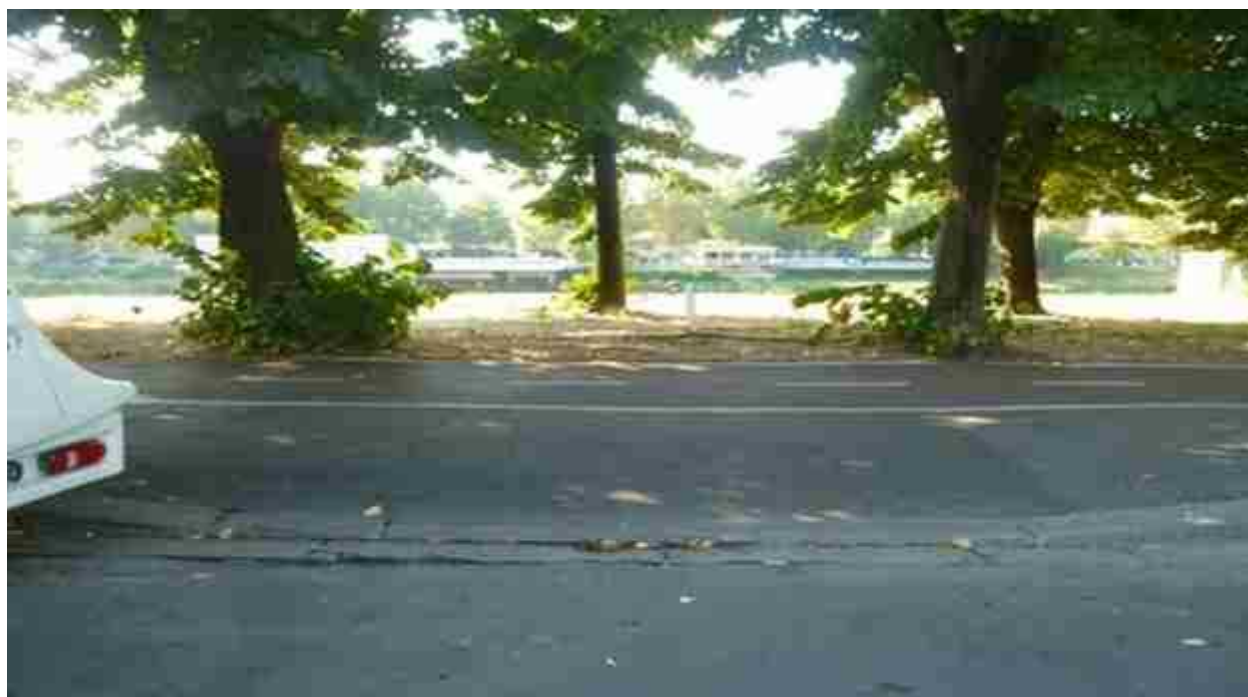
16.2_01 realizzazione spalletta varco
