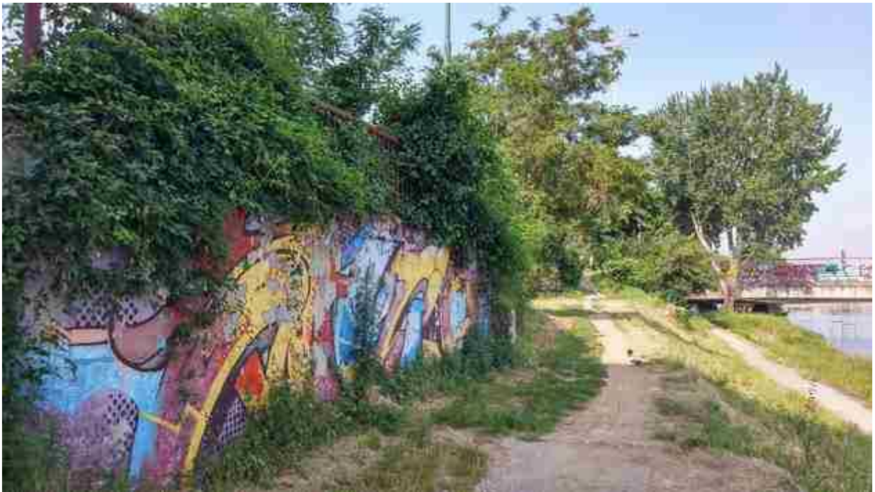
08_03 rialzo muro a monte del Ponte Giovanni da Verrazzano
