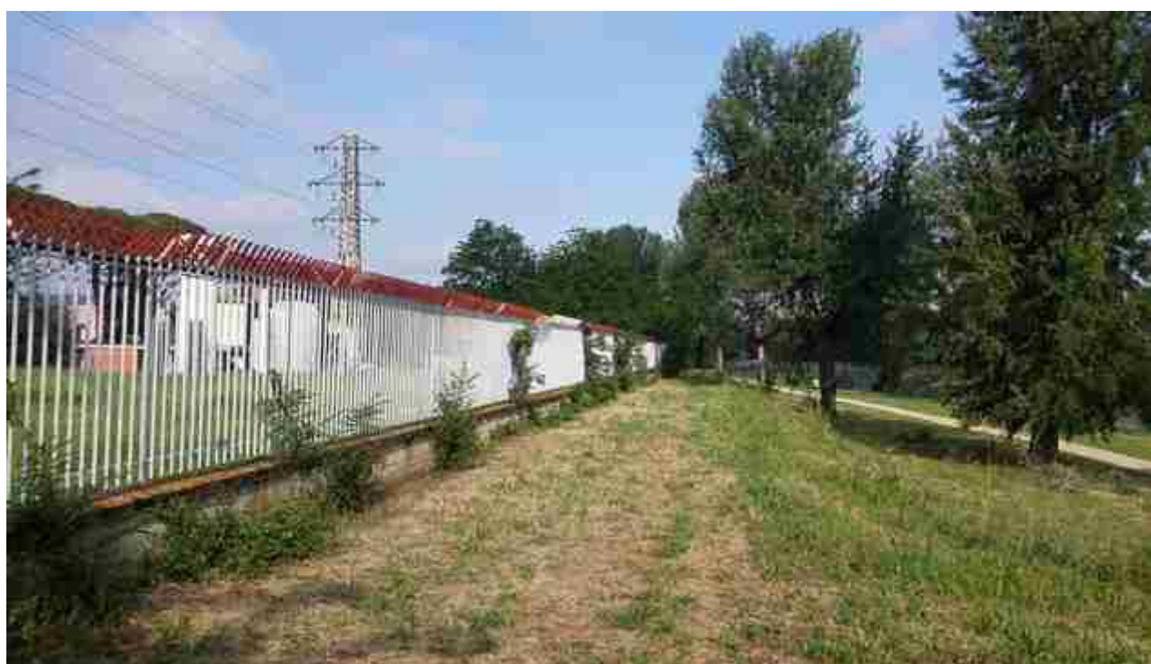
06_04 muro impianto dell'Anconella
