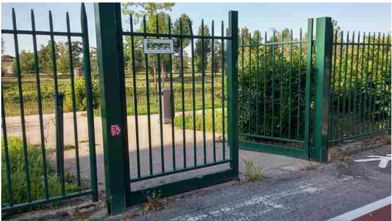
08_05 rialzamento cordolo varco2
