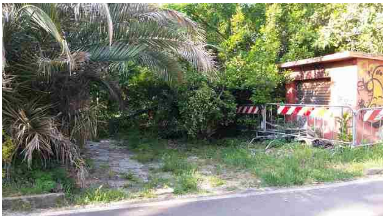
19_05 realizzazione spalletta varco
