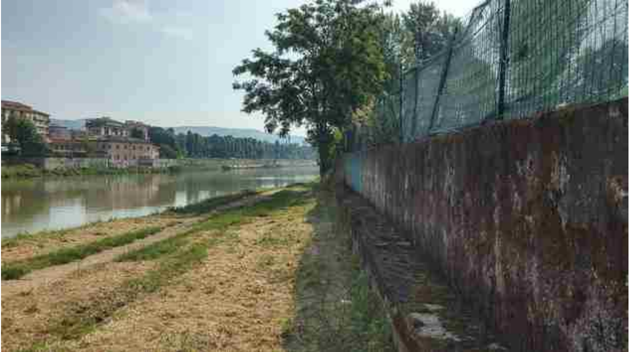
08_05 rialzo muro a monte del Ponte Giovanni da Verrazzano
