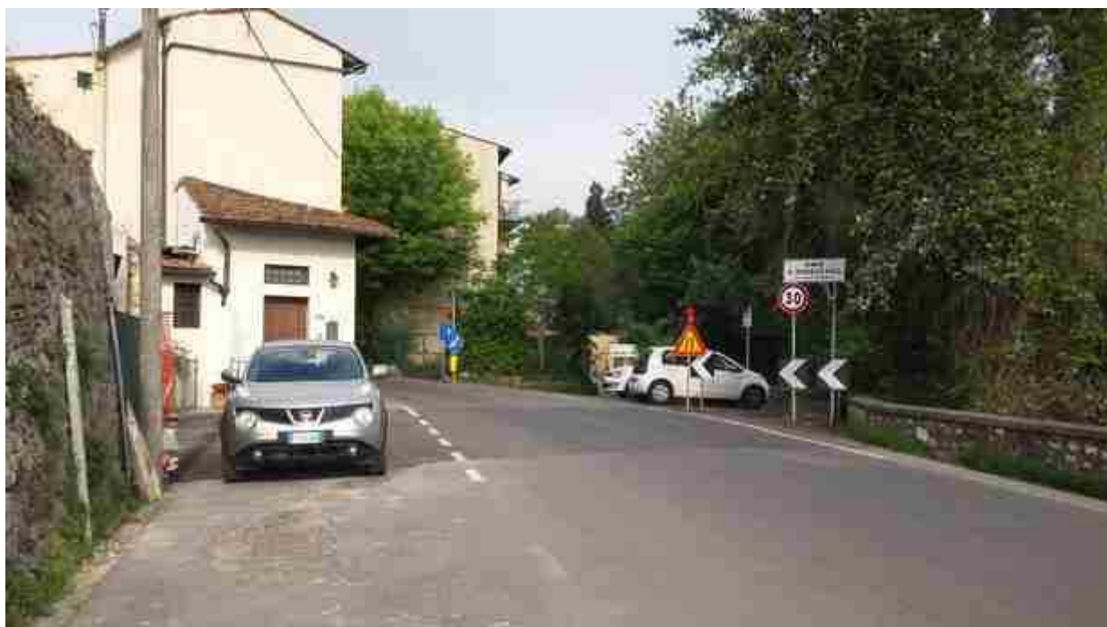
02_02 rialzo muro Nave a Rovezzano
