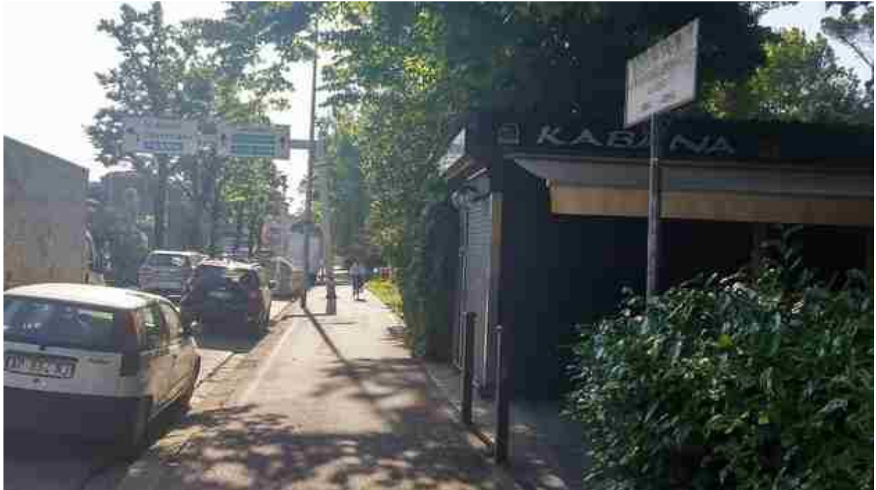
20_02 realizzazione spalletta vista verso monte
