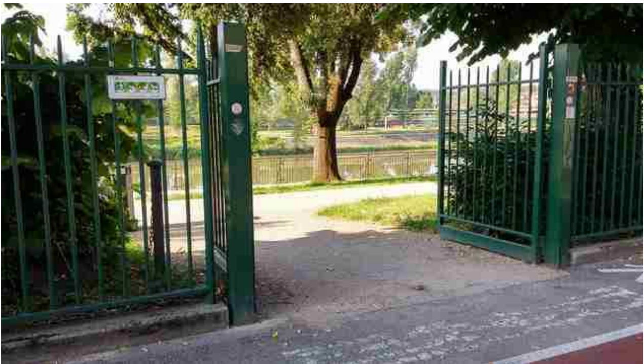
08_11 rialzamento cordolo varco7
