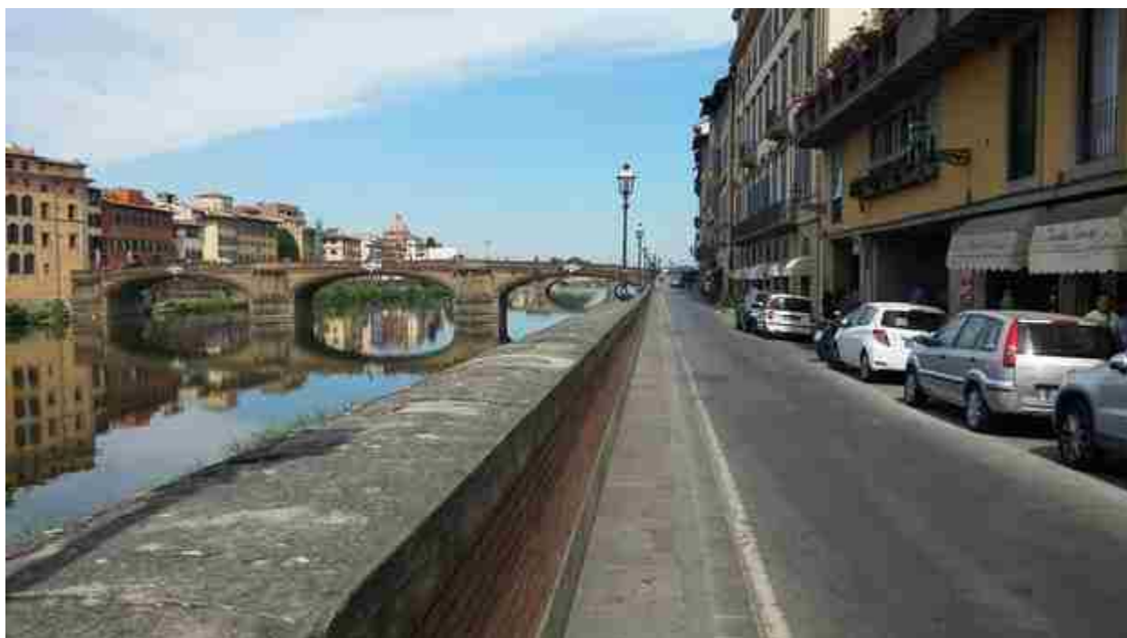
25_03 rialzo spallette Lungarno Acciaiuoli
