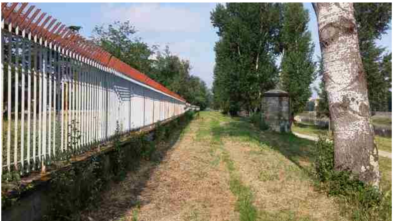
06_06 muro impianto dell'Anconella
