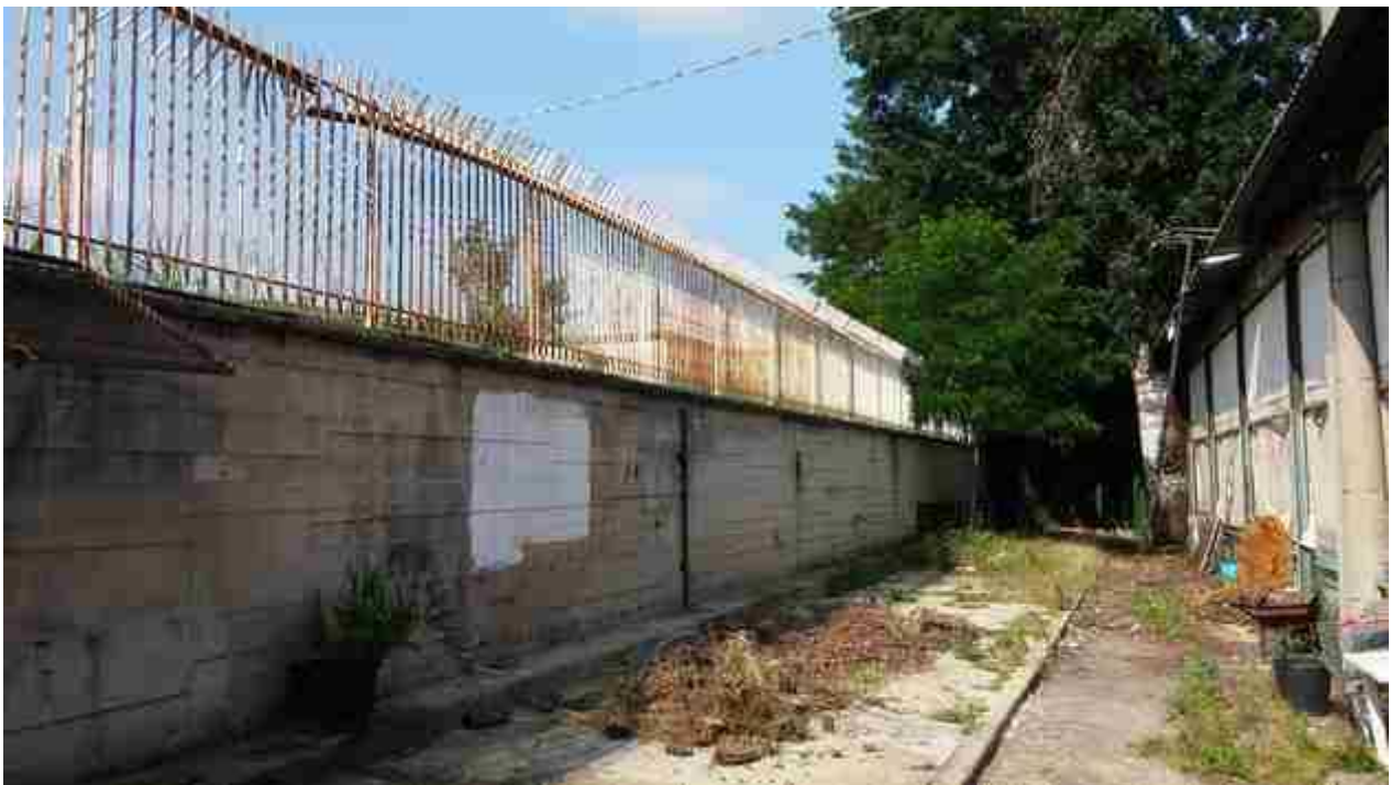
06_14 muro impianto dell'Anconella
