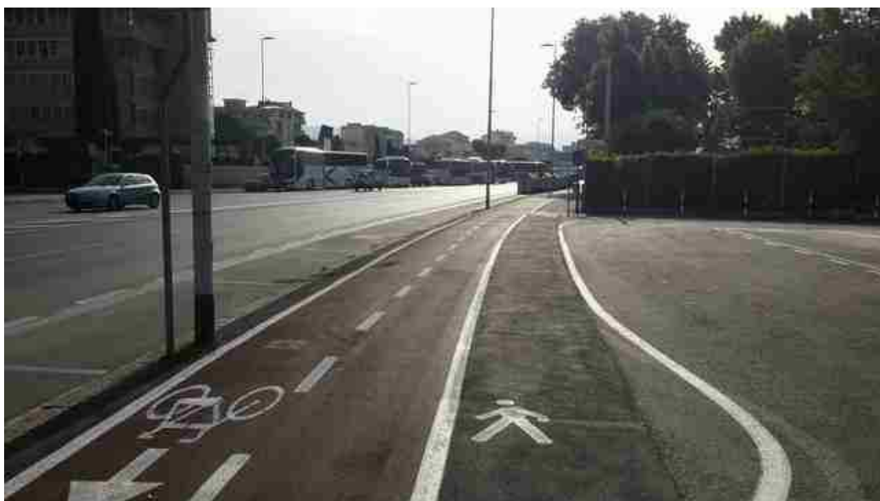
06_04 realizzazione spalletta vista verso monte
