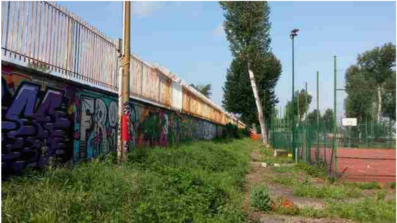
06_11 muro impianto dell'Anconella
