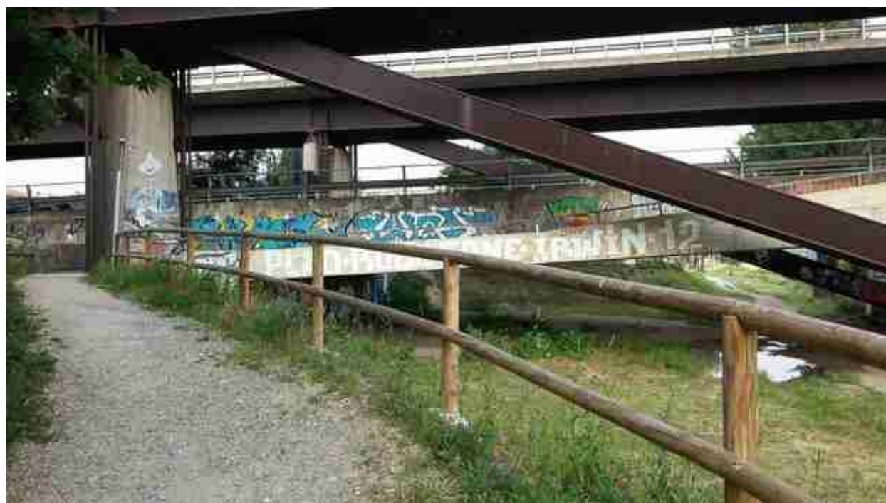
04_05 rialzo argine ultima parte
