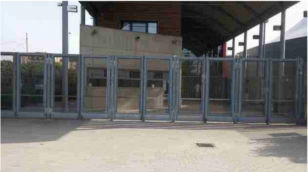
05_01 rialzamento arginale varco
