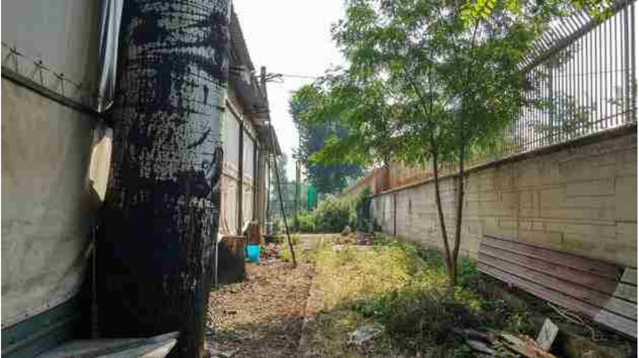
06_15 muro impianto dell'Anconella vista verso monte
