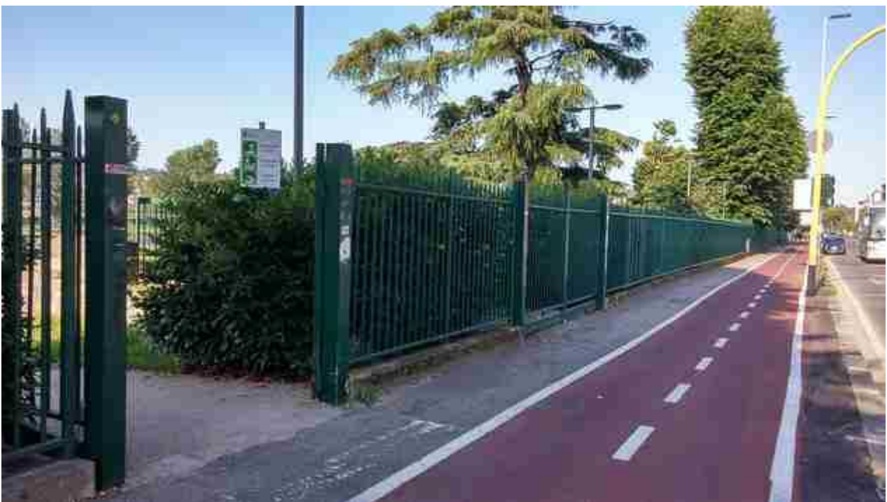
08_13 rialzamento cordolo varco8
