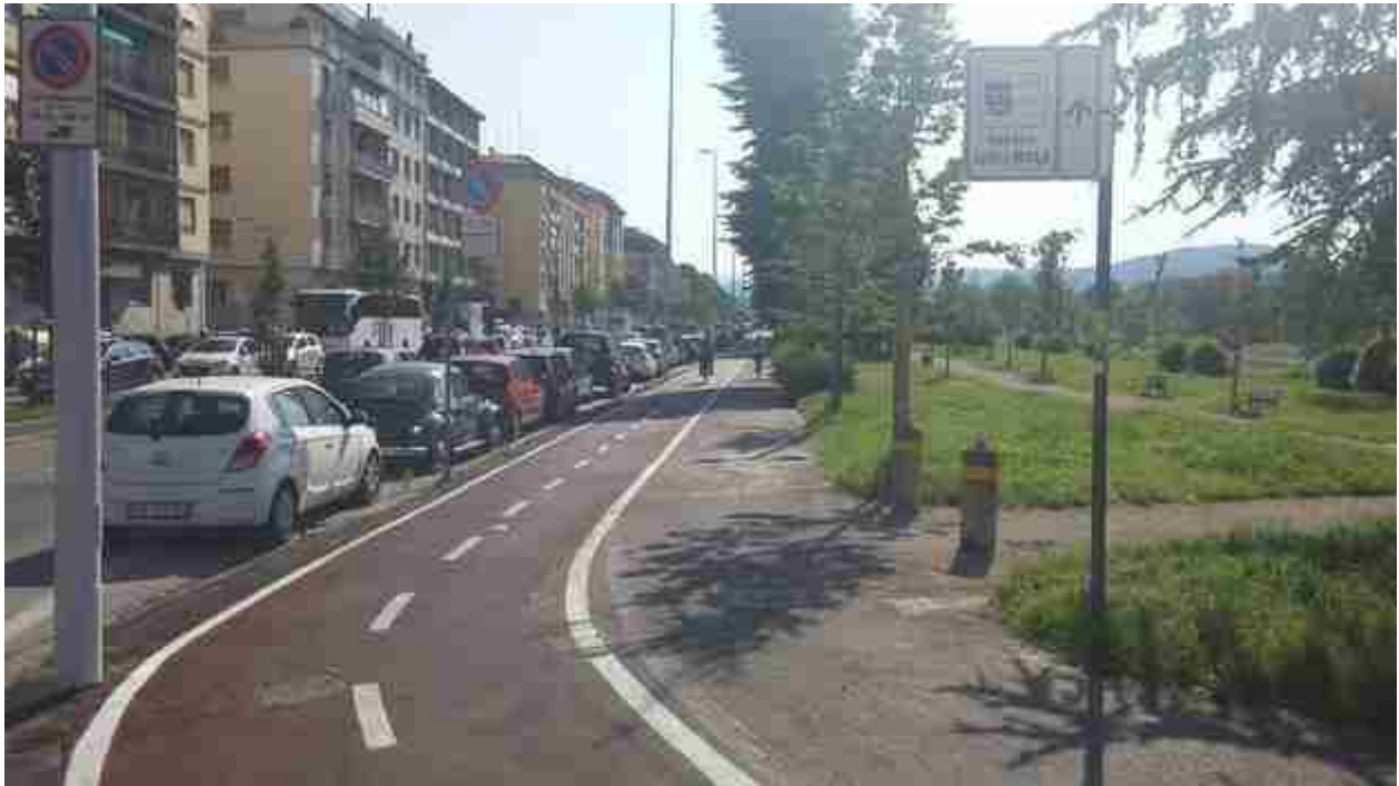
10_02 realizzazione spalletta vista verso monte
