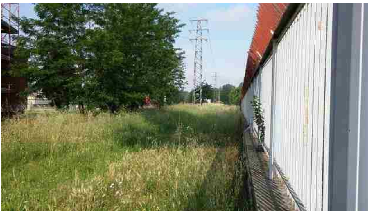
06_03 muro impianto dell'Anconella vista verso monte
