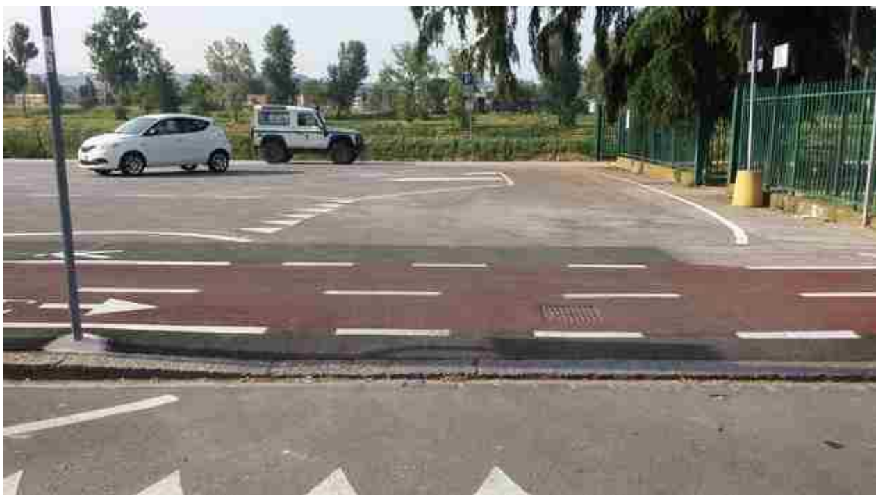
07_01 realizzazione spalletta varco
