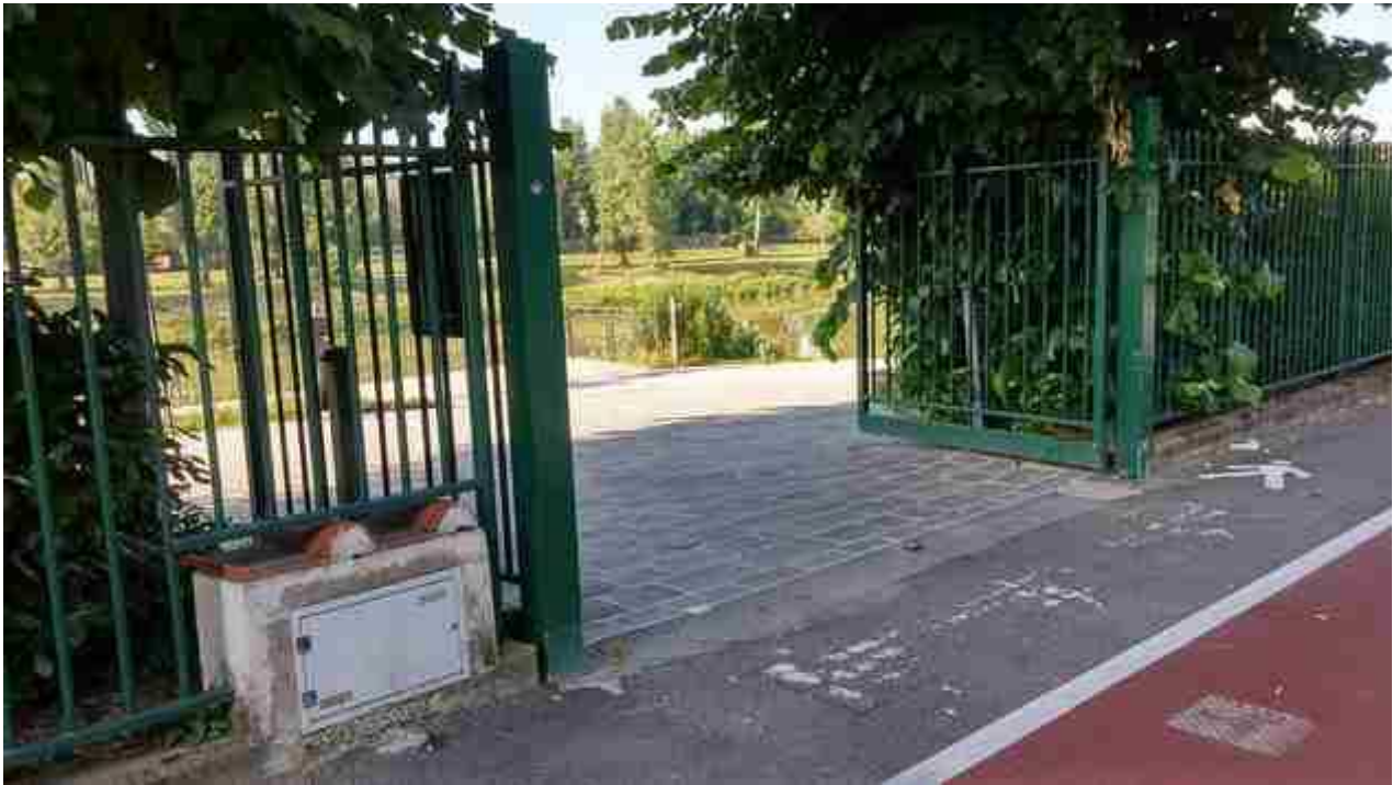
08_08 rialzamento cordolo varco4
