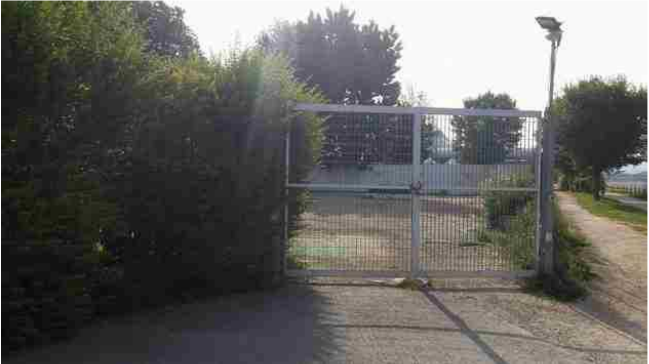
06_01 realizzazione spalletta varco
