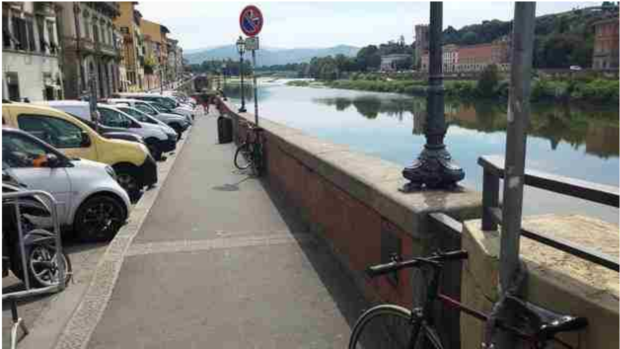
24_09 rialzo spalletta Lungarno alle Grazie vista verso monte
