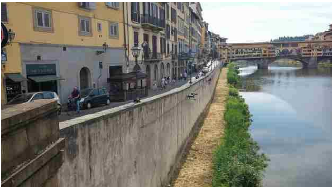
25_06 rialzo spallette Lungarno Acciaiuoli vista verso monte lato fiume
