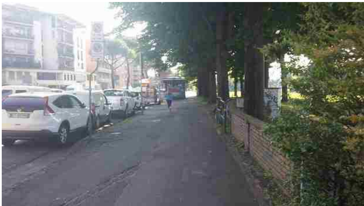
16.3_01 realizzazione spalletta verso monte
