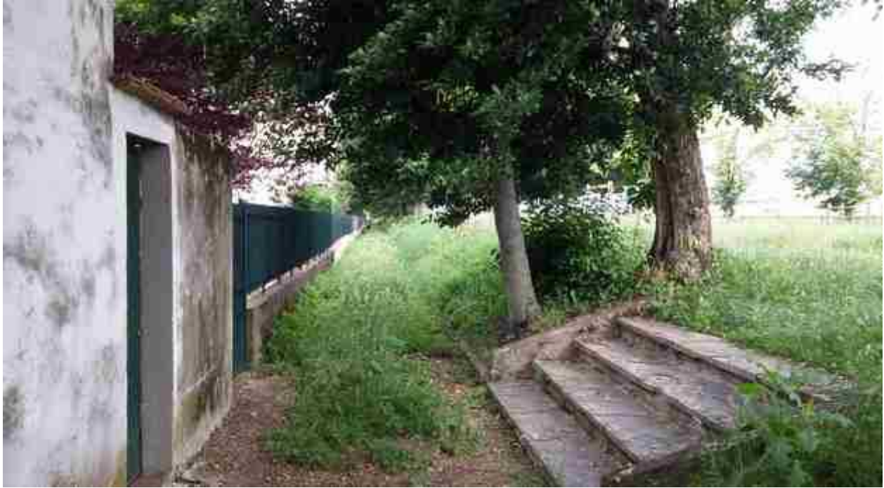
03_03 particolare petto argine a campagna con scalinata
