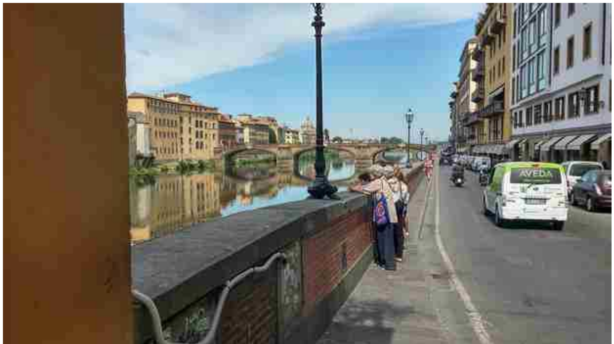
25_02 rialzo spallette Lungarno Acciaiuoli
