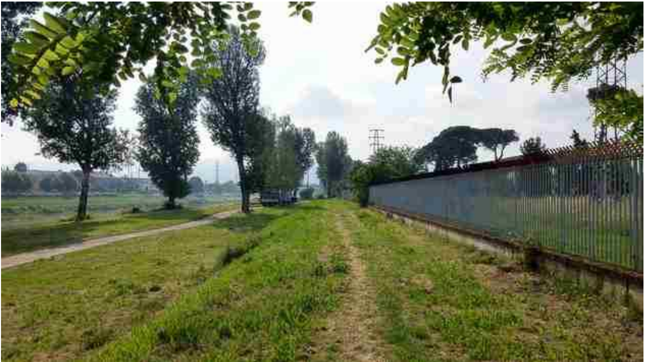
06_05 muro impianto dell'Anconella vista verso monte
