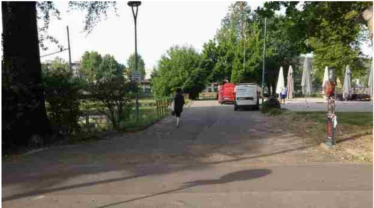
18_01 realizzazione spalletta varco
