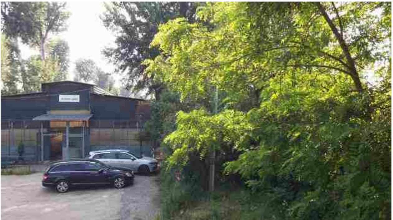
07_01 muro argine vista verso monte
