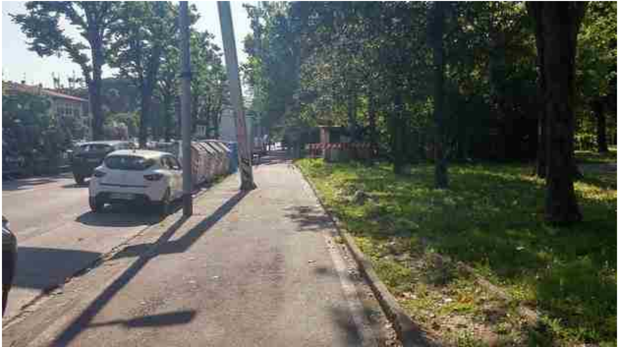
19_07 realizzazione spalletta vista verso monte
