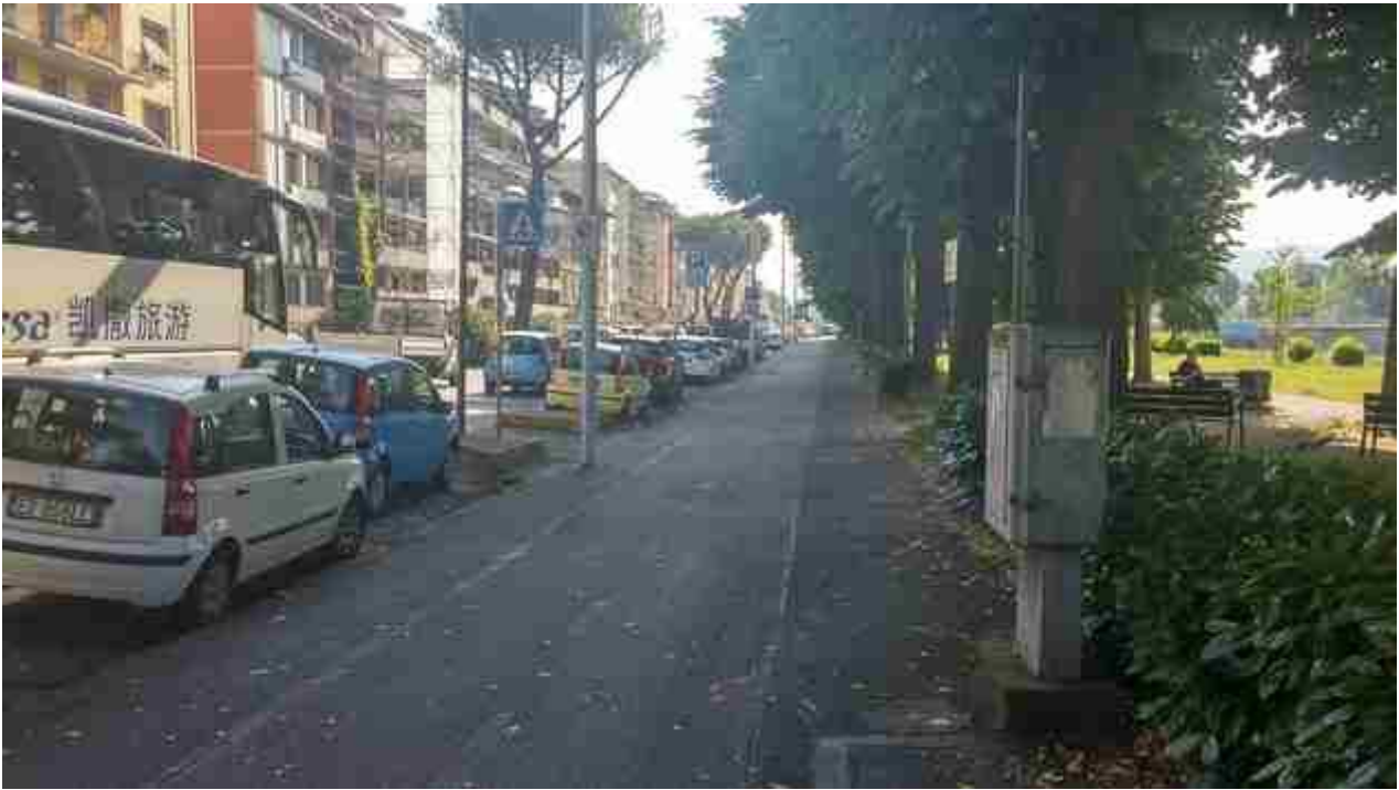
11_02 realizzazione spalletta vista verso monte
