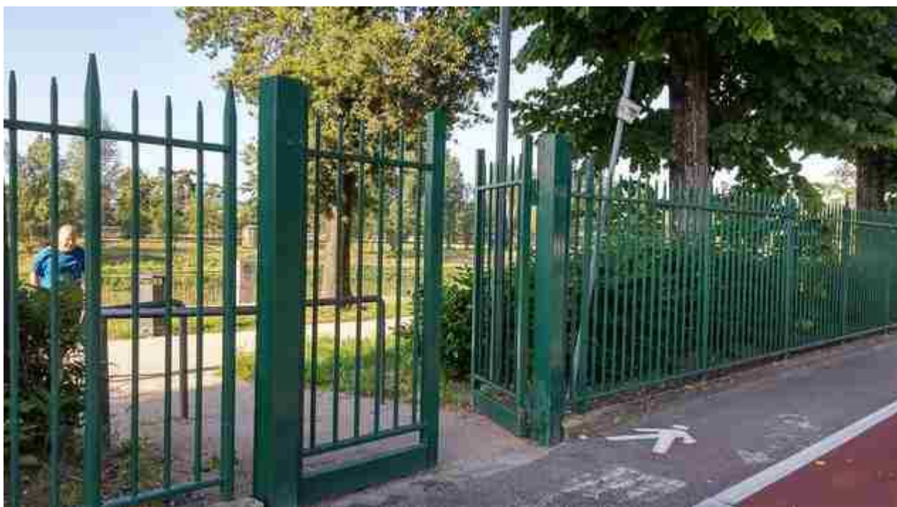
08_02 rialzamento cordolo varco1
