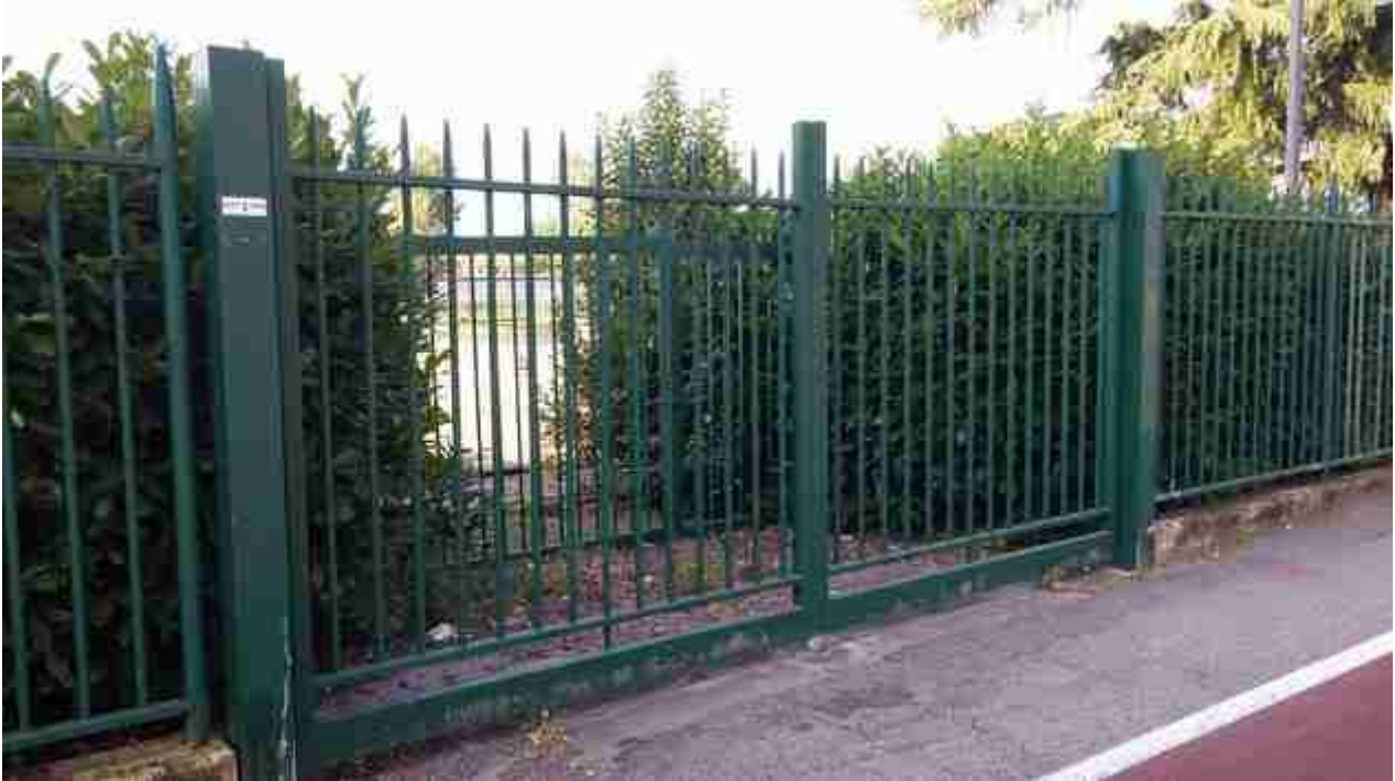
08_14 rialzamento cordolo varco9
