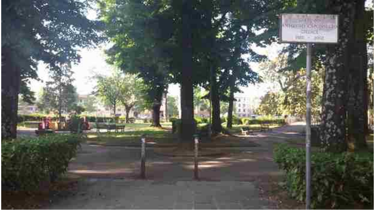
22_02 realizzazione spalletta varco
