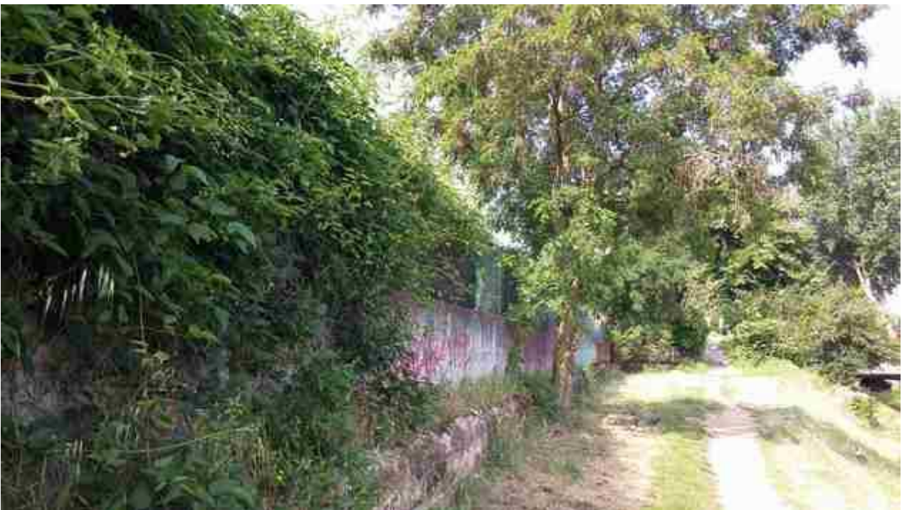
08_04 rialzo muro a monte del Ponte Giovanni da Verrazzano vista lato golena
