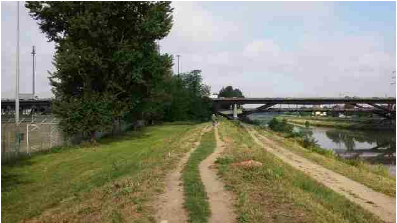
04_02 rialzo argine zona campo sportivo
