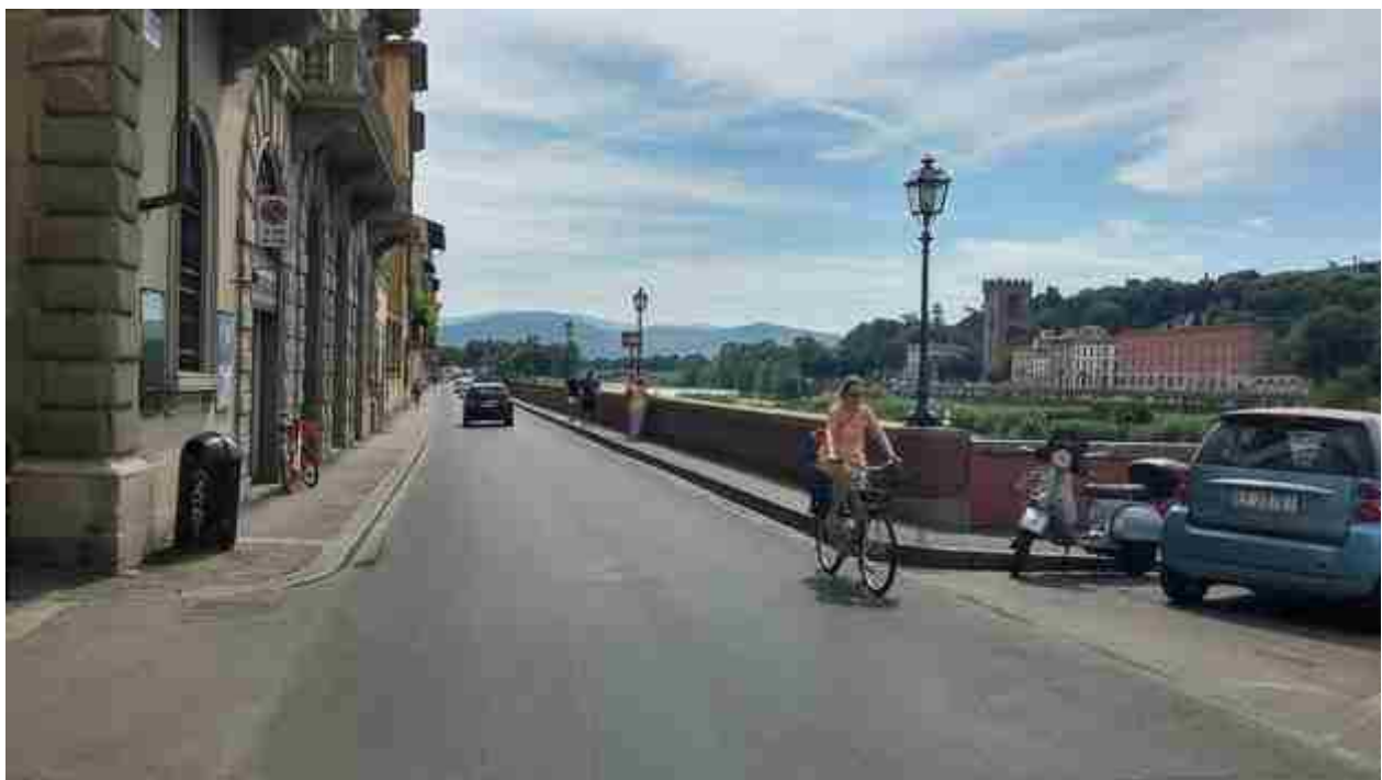
24_04 rialzo spalletta Lungarno alle Grazie vista verso monte
