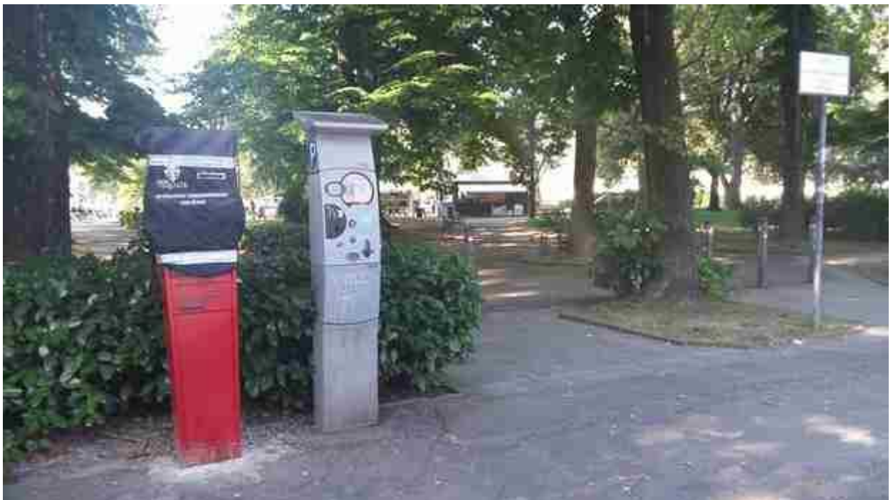
22_05 realizzazione spalletta varchi
