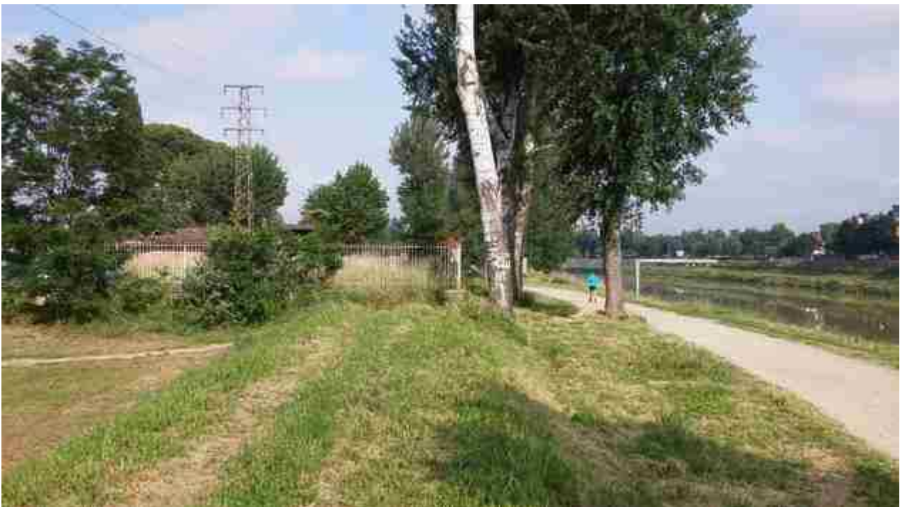
05_10 rialzo argine ultima parte
