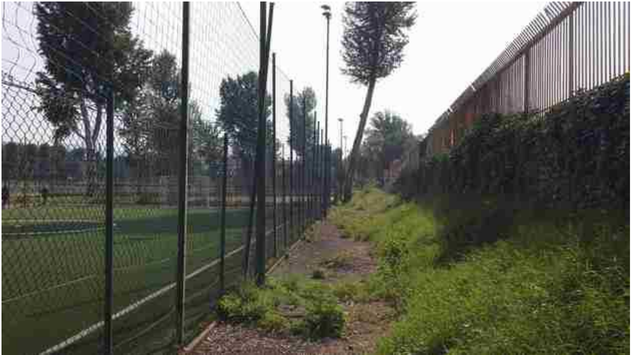
06_13 muro impianto dell'Anconella vista verso monte
