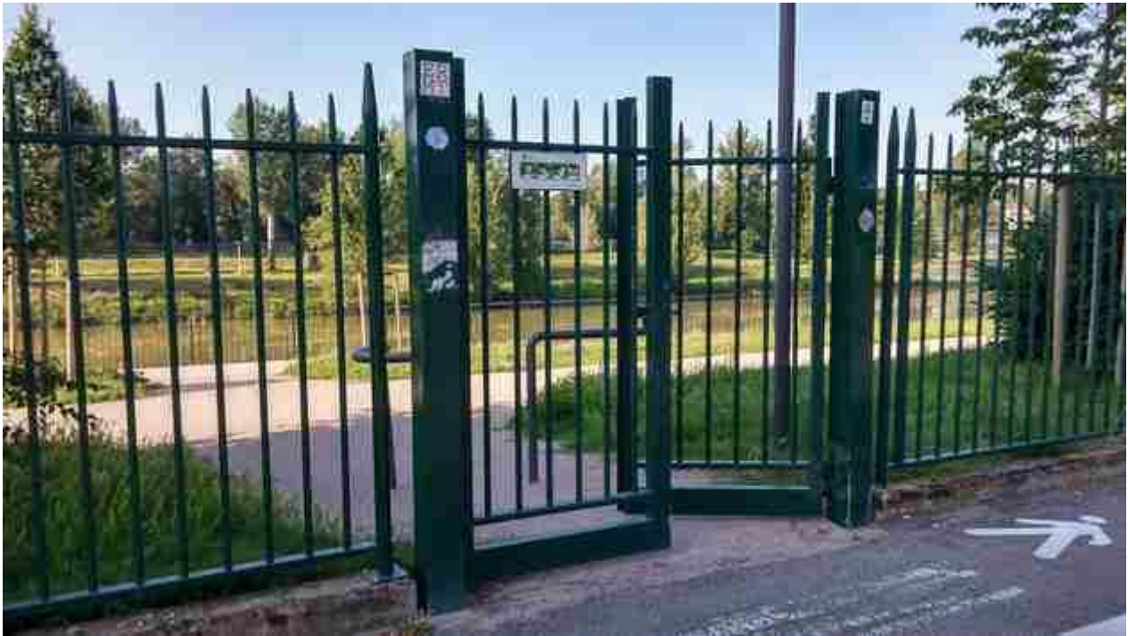
08_10 rialzamento cordolo varco6
