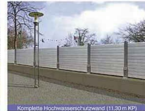
Komplette Hochwasserschutzwand (11,30 m KP)
