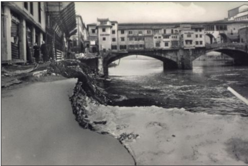
1966 Lungarno Acciaiuoli, crollo delle spallette e del muraglione
