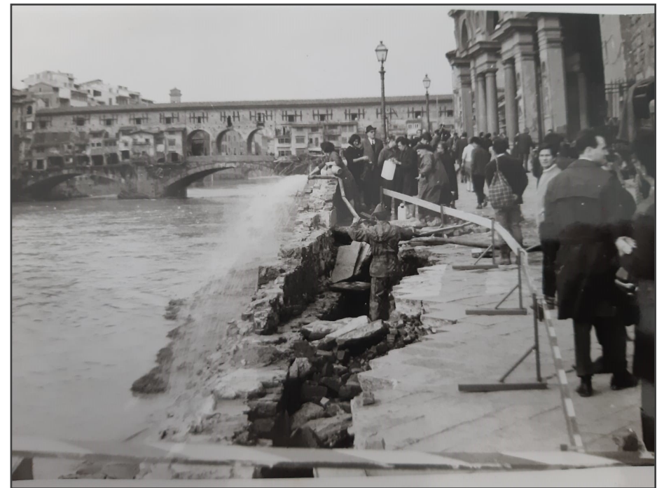
1966 Lungarno A.M. Luisa de' Medici, crollo delle spallette e del muraglione
