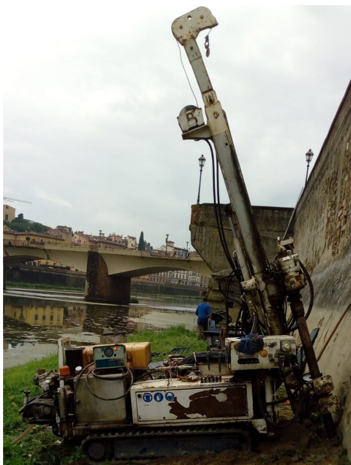
Foto 1: Postazione Impianto cantiere
