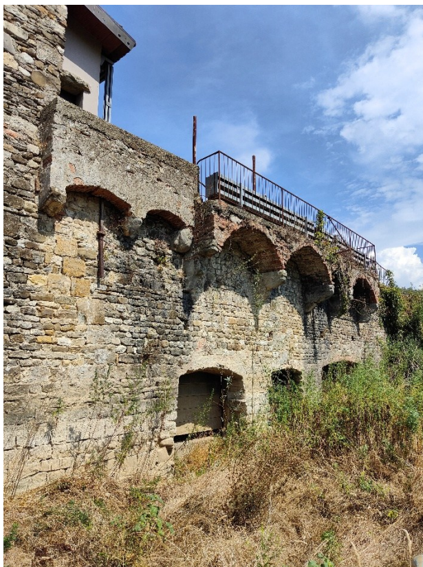
Particolari prese della Gora sul muro delle Gualchiere di Remole
