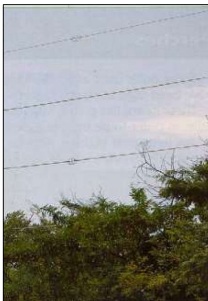
Figura 19: Schema di spirale ed elettrodotto dotato di spirali che sovrasta il bordo di un bosco (Fonte: “Linee Guida per la mitigazione dell’impatto delle linee elettriche sull’avifauna”. ISPRA e Ministero dell’Ambiente e della Tutela del Territorio e del Mare)
