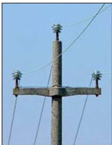
Figura 21: Isolatore portante semplice (Fonte: "Linee Guida per la mitigazione dell'impatto delle linee elettriche sull'avifauna". ISPRA e Ministero dell'Ambiente e della Tutela del Territorio e del Mare)
