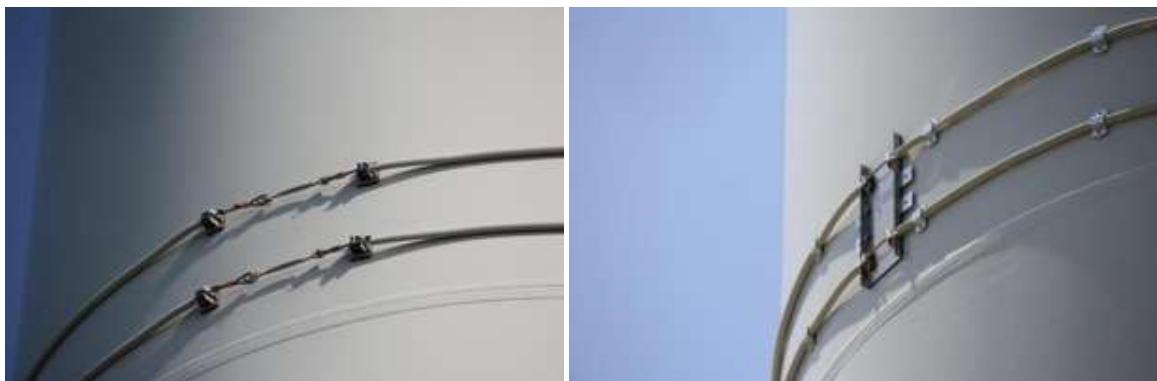
Figura 3: Funi metalliche e piastra posteriore fissa esterna nvbird WTG
