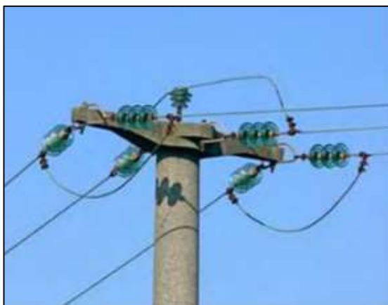
Figura 23: Isolatore rigido per amarro (Fonte: "Linee Guida per la mitigazione dell'impatto delle linee elettriche sull'avifauna". ISPRA e Ministero dell'Ambiente e della Tutela del Territorio e del Mare)
