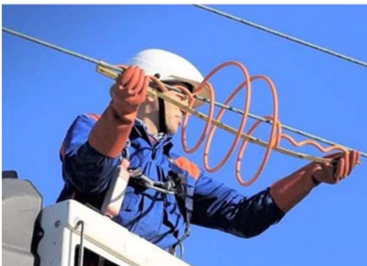
Figura 18: Installazione del dispositivo di dissuasione (spirale)
