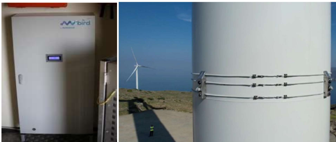
Figura 5: Unità di controllo posta all'interno della torre eolica e sistema nvbird WTG installato ed in funzione
