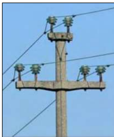
Figura 22: Isolatore portante doppio (Fonte: "Linee Guida per la mitigazione dell'impatto delle linee elettriche sull'avifauna". ISPRA e Ministero dell'Ambiente e della Tutela del Territorio e del Mare)
