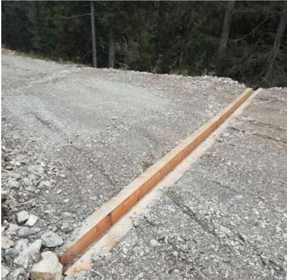
Figura 12 Tipica canaletta in larice per strade bianche (fonte: Consorzio Forestale Alta Valtellina)
