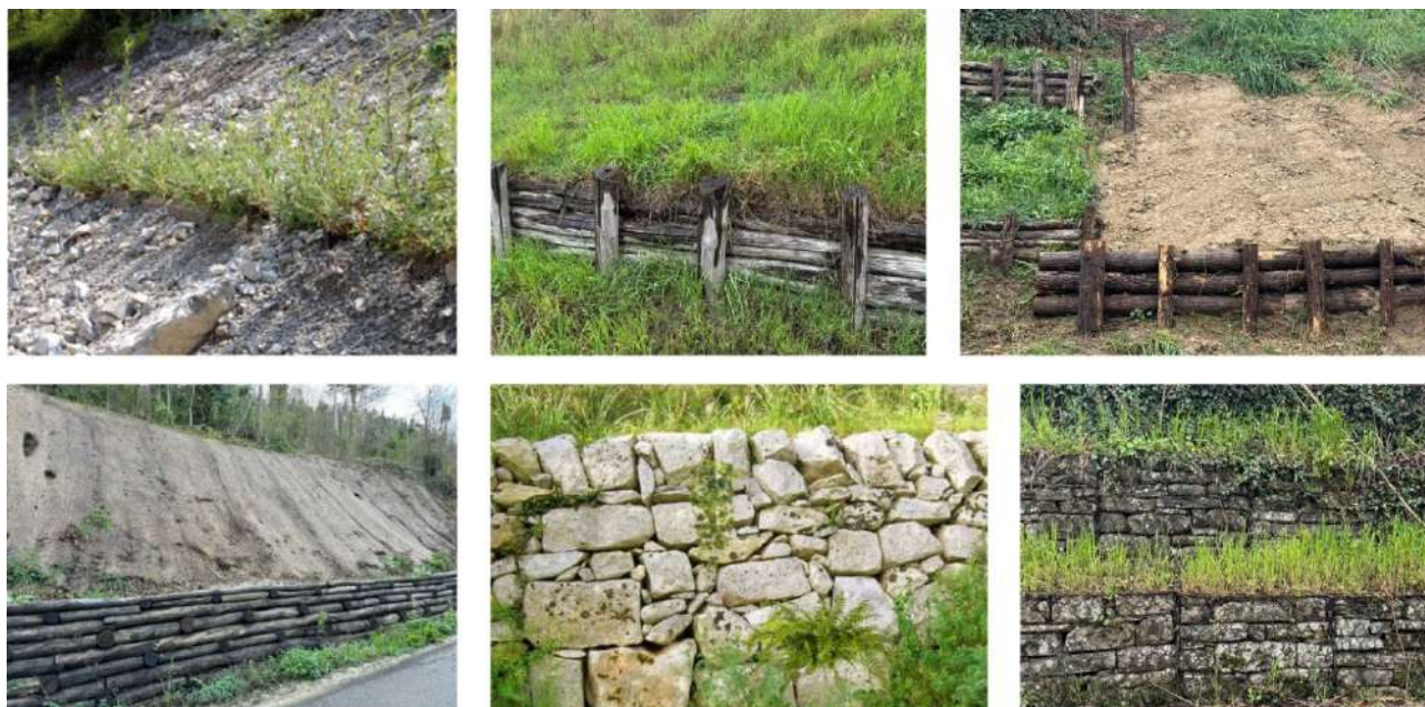
Figura 13 Esempi realizzati di tecniche di ingegneria naturalistica: da sinistra in senso orario: cordonata viva ben attecchita (Foto di R. Ferrari per Regione Lazio), palificata semplice post e pre-inverdimento, palificata alla base del pendio, muretto a secco rinverdito, gabbioni di pietrame
