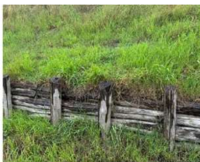
Figura 1. Esempi di tecniche di ingegneria naturalistica, da sinistra verso destra: Cordonata viva ben attecchita, palificata semplice post e pre-inverdimento
