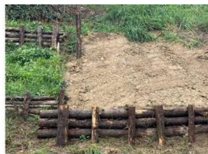
Figura 1. Esempi di tecniche di ingegneria naturalistica, da sinistra verso destra: Cordonata viva ben attecchita, palificata semplice post e pre-inverdimento
