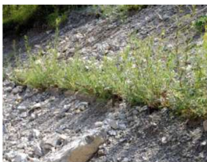
Figura 1. Esempi di tecniche di ingegneria naturalistica, da sinistra verso destra: Cordonata viva ben attecchita, palificata semplice post e pre-inverdimento
