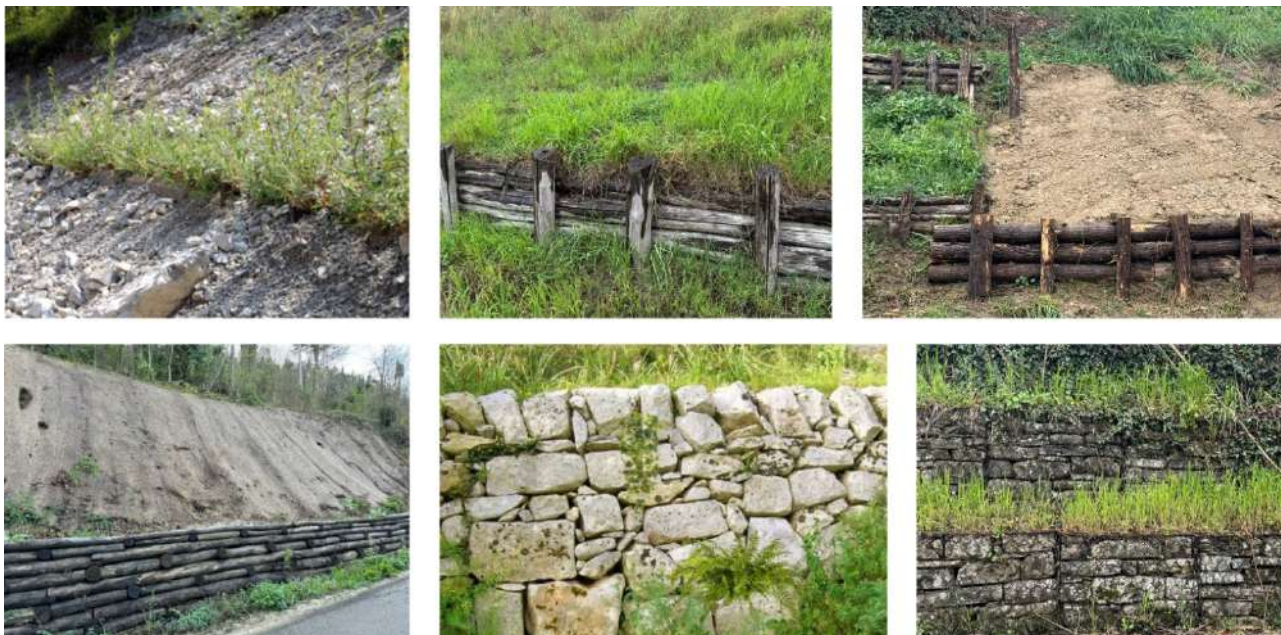
Figura 9 Esempi realizzati di tecniche di ingegneria naturalistica: da sinistra in senso orario: cordonata viva ben attecchita (Foto di R. Ferrari per Regione Lazio), palificata semplice post e pre-inverdimento, palificata alla base del pendio, muretto a secco rinverdito, gabbioni di pietrame
