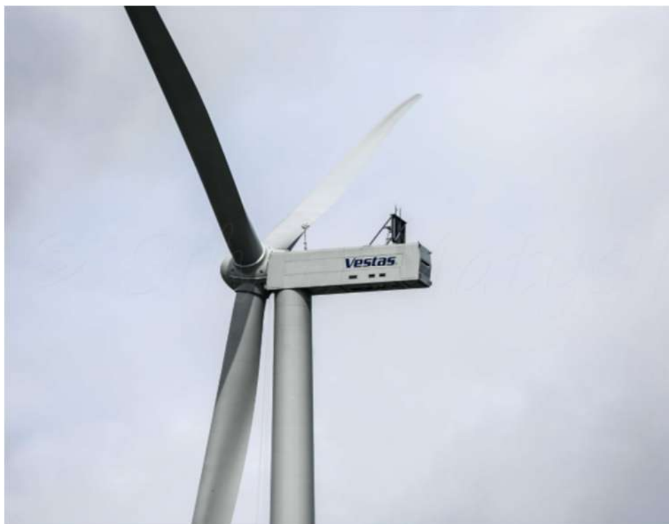
Figura 2 Vista del rotore e della navicella di una turbina Vestas V162
