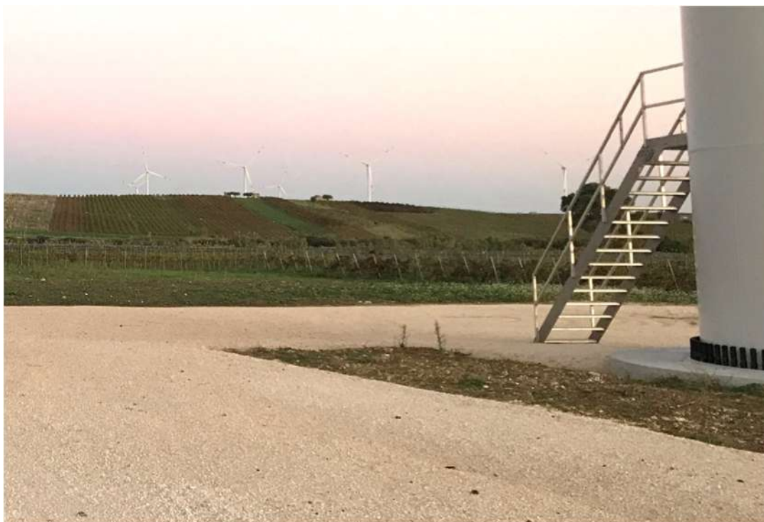
Figura 7 Esempio di pista e piazzale in stabilizzato di cava
