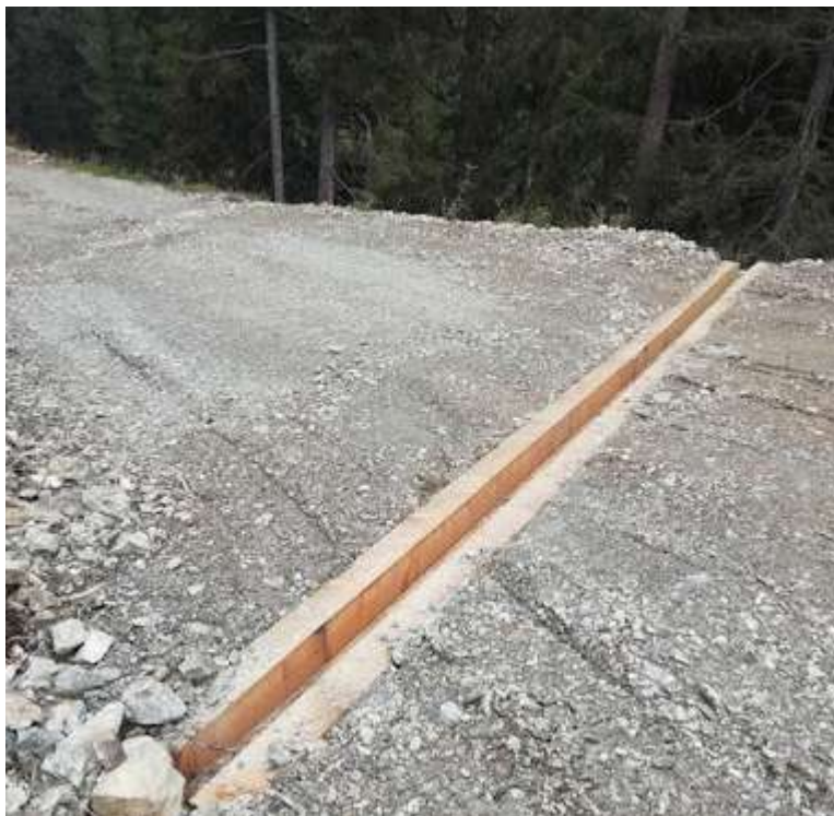
Figura 16 Tipica canaletta in larice per strade bianche (fonte: Consorzio Forestale Alta Valtellina)
