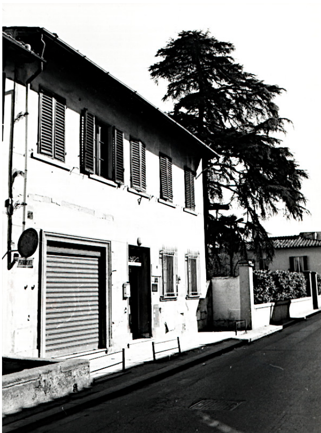
Edificio che ospitò dapprima la S.M.S. di Brozzi, poi la Casa del Fascio, alloggio delle truppe
