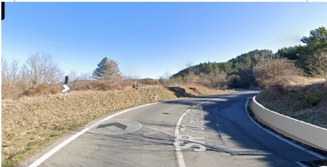
FOTO 1- curva dal km 10+220 al km 10+290 stato di progetto: costruzione di un muro di valle strutturalmente concepito in cemento armato e realizzazione di due banchina laterali di larghezza pari almeno a 1,00 m su entrambi i lati della carreggiata
