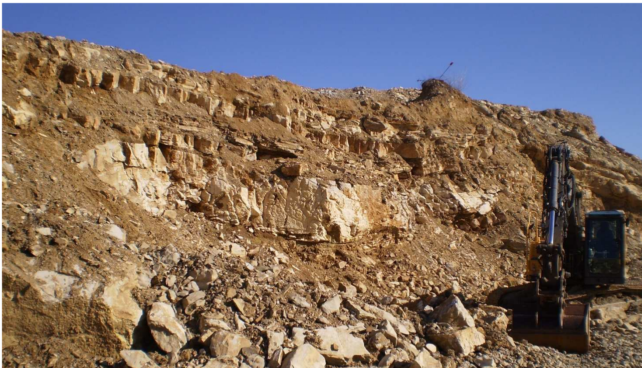
Fig 13: Fronte di scavo all'interno del Cantiere B (stratificazione S0 sub-orizzontale)
