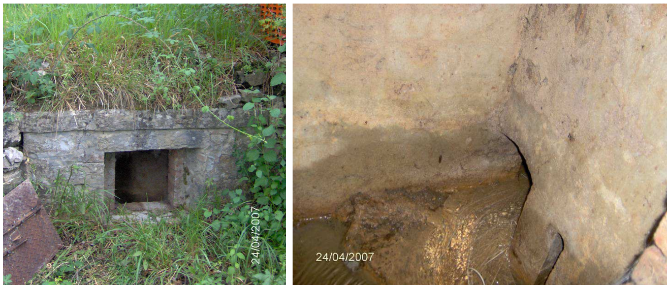
Figura 45- A sinistra, opera di presa che ospita la sorgente; a destra, interno dell'opera da cui esce l'acqua
