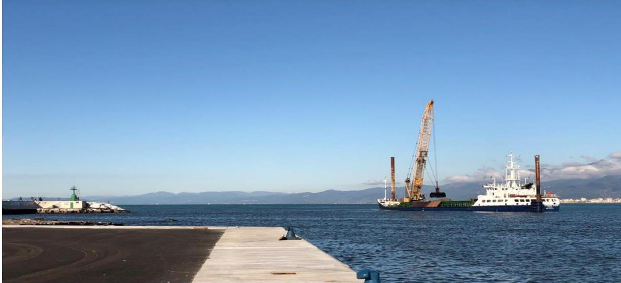
lavori di escavo imboccatura con draga autocaricante autopropulsa
