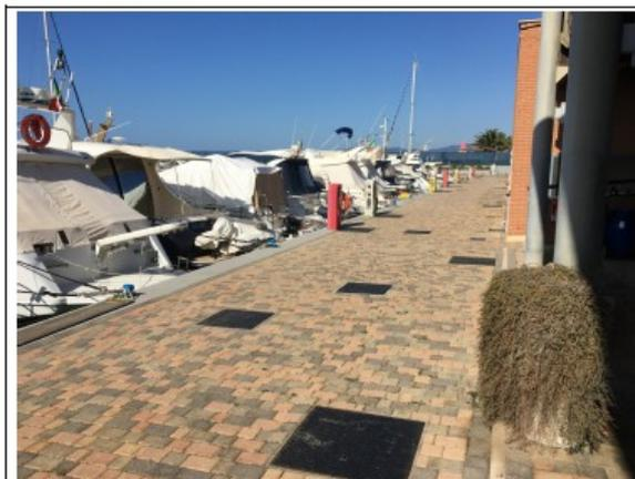
Foto 3.1) Percorsi/aree pedonali alla quota delle banchine del porto pavimentate con masselli autobloccanti in calcestruzzo
