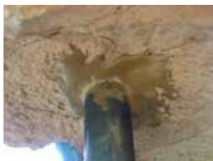
fig. 9 particolare del perno di sostegno inserito con resina poliestere
