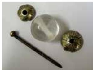
fig. 5 una delle sfere di cristallo perimetrali, separata dagli elementi di metallo che la ancorano alla struttura
