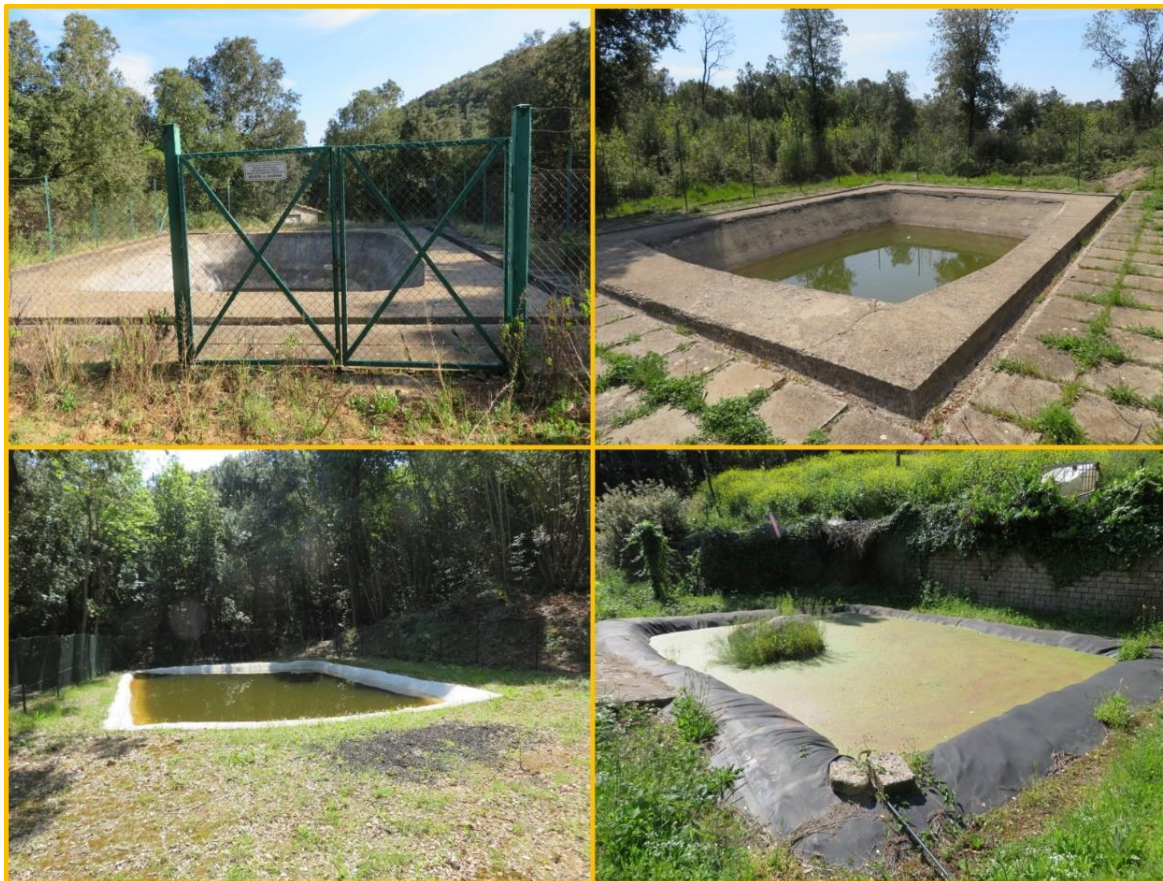
Figura 8.7 - Alcuni degli invasi operativi nello stato di conservazione attuale.
