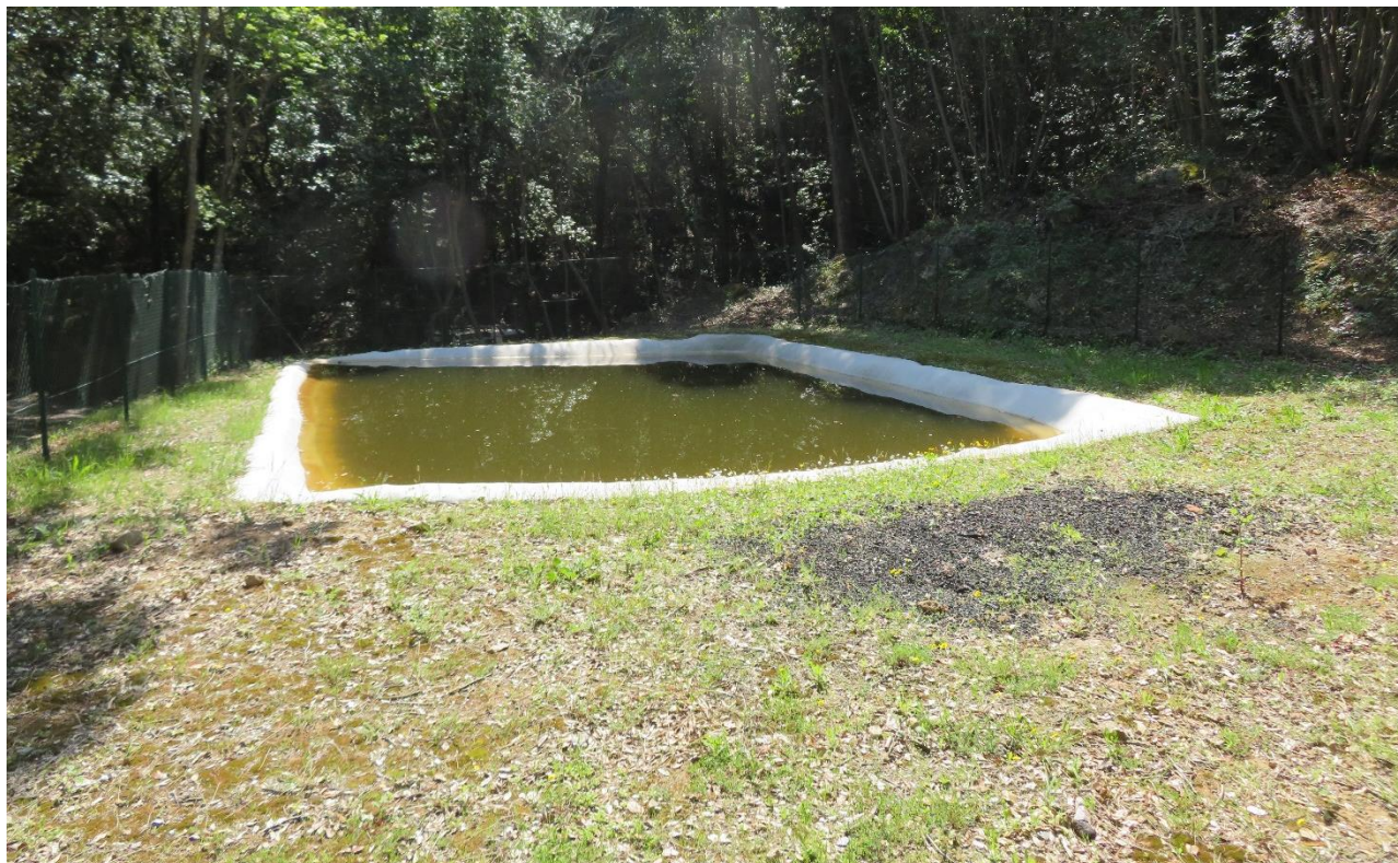
Figura 6.13 - Invaso AIB presso il Convento.
