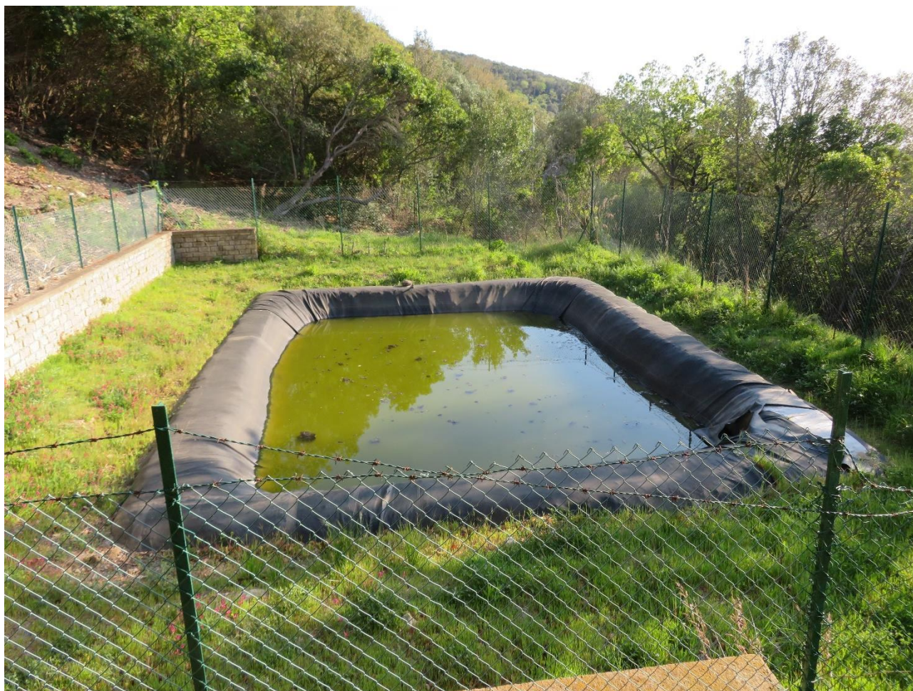
Figura 6.8 - Invaso AIB presso i Culminali.
