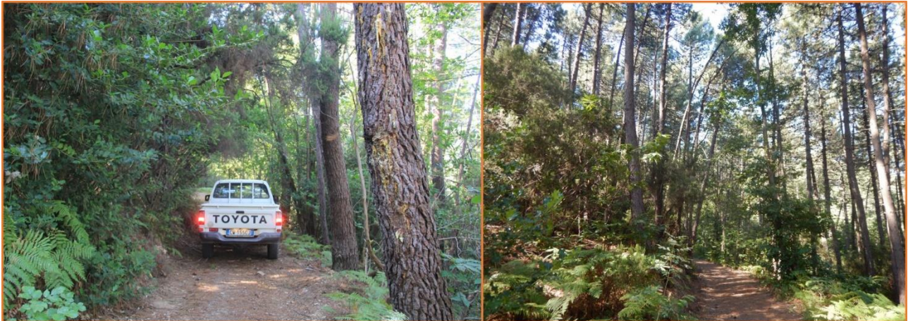
Figura 8.6 - Viabilità forestale con fasce laterali non trattate, che aumentano il rischio per le squadre impegnate nella lotta attiva.
