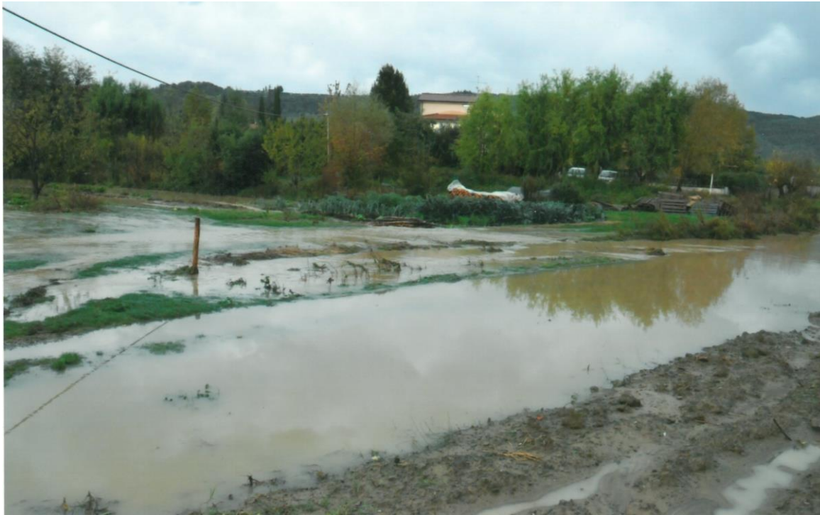
Figura 2-8: allagamento dell'area in cui sarà realizzato il tratto iniziale del nuovo canale di acque basse (evento 27-28 luglio 2019).
