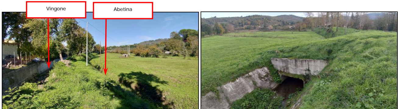
Foto 9. Vingone tratto a valle sottoattraversamento Abetina VvV.
