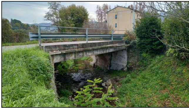
Foto 1. Ponte SC di Bagnoro VvM.
