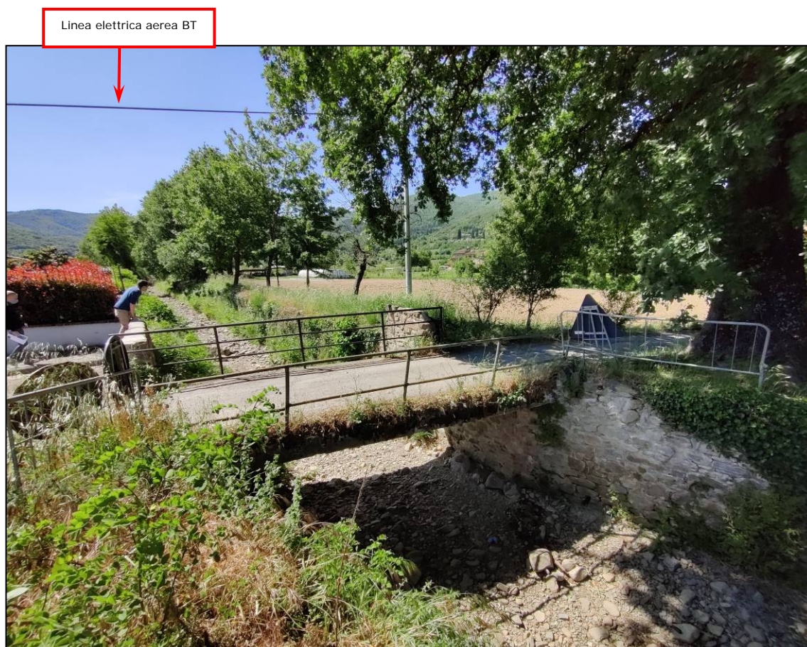
Foto 29. Ponte strada vicinale esistente tra sez. 3481 e 3468.
