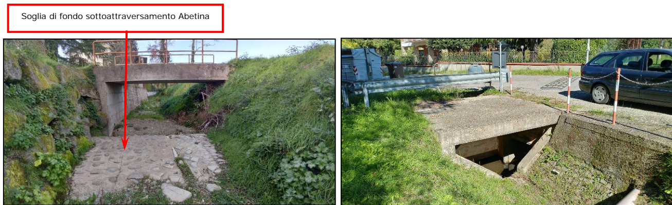
Foto 11. Vingone alveo in corrispondenza di sottoattraversamento Abetina VvV.
