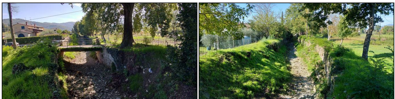
Foto 13. Ponte SC vicinale VVM.
