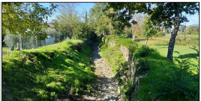
Foto 14. Vingone tratto a valle ponte SC vicinale VvV.
