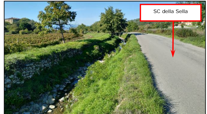
Foto 20. Vingone tra ponte SC della Sella e Gragnone VvV.
