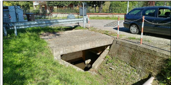
Foto 12. Abetina pozzetto ingresso sottoattraversamento VVM.
