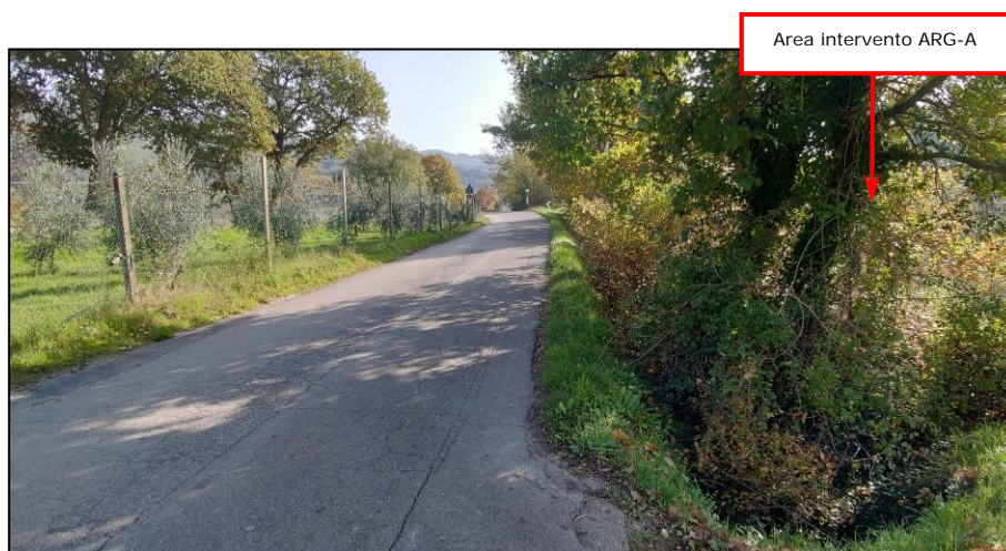
Foto 29. Strada comunale della Sella all'altezza dell'intervento ARG-A
