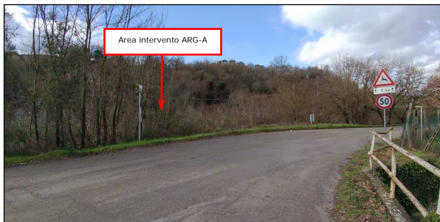
Foto 31. Strada comunale della Sella all'altezza dell'intervento ARG-A. Vista dal ponte.
