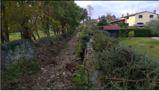
Foto 15. Vingone tratto a monte di ponte SC vicinale VvV.
