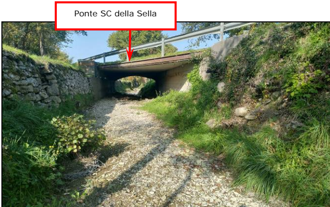
Foto 17. Vingone tratto a monte di ponte SC della Sella VvV.
