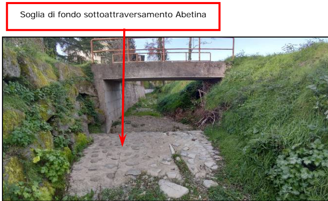
Foto 11. Vingone alveo in corrispondenza di sottoattraversamento Abetina VvV.
