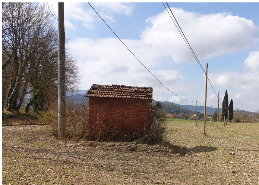
Figura 33 Manufatto da demolire
