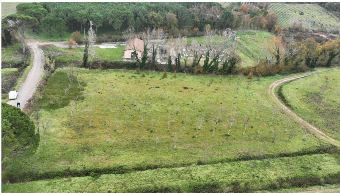
Figura 2.1.2/1 – Veduta aerea dell'area su cui sorgerà la nuova stazione
