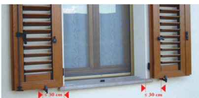
"Fondamenti di Prevenzione Infortuni Domestici" Regione
