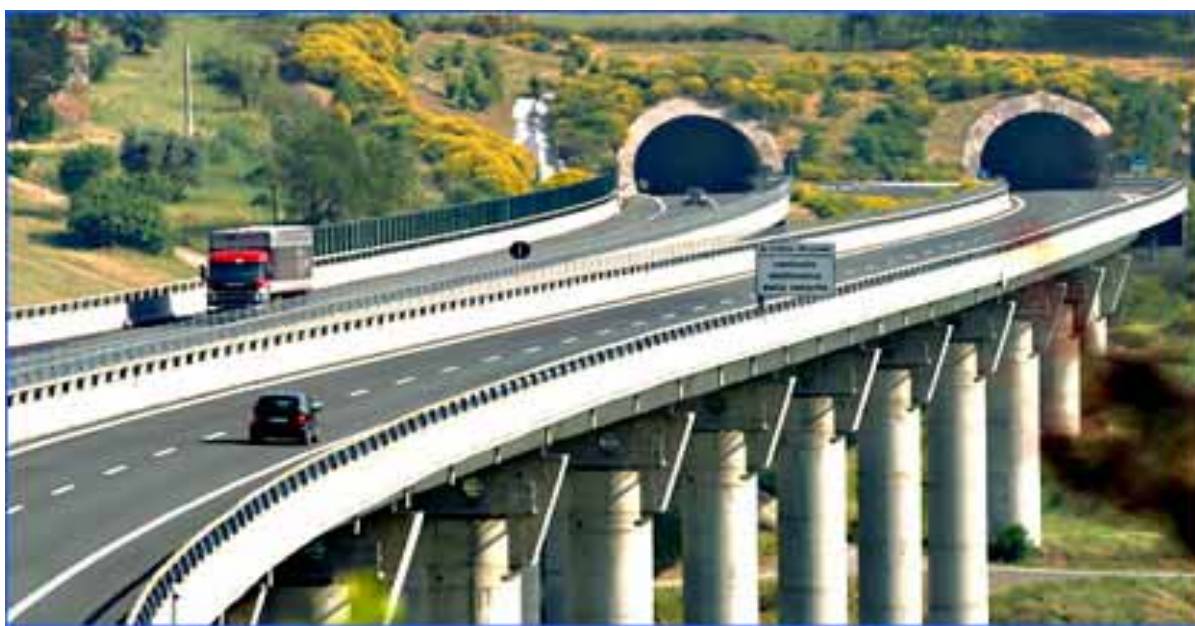
Un viadotto dell'autostrada Tirrenica
